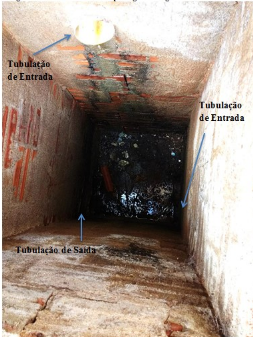
Imagem 14: Interior da caixa de passagem de esgoto.
