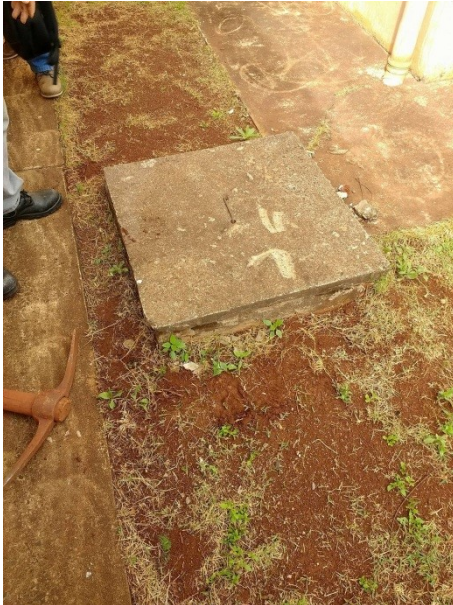
Imagem 13: (a) Caixa de passagem de água pluvial 1; (b) Caixa de passagem de esgoto e água pluvial 2.
