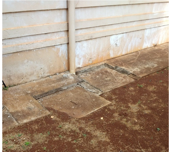
Imagem 13: (a) Caixa de passagem de água pluvial 1; (b) Caixa de passagem de esgoto e água pluvial 2.
