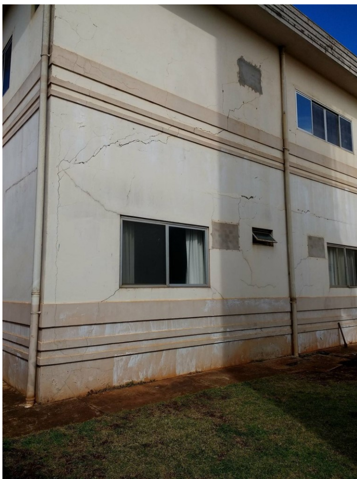
Imagem 3: Parede externa da ala de enfermaria.
