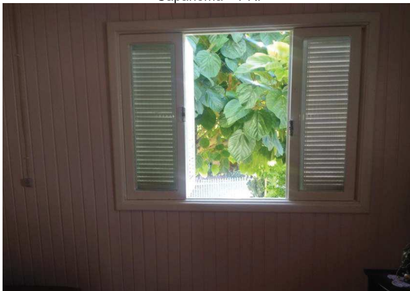
Figura 30 – Vista interna de uma parede em madeira em uma casa de tábua e mata-junta em Capanema – PR.
