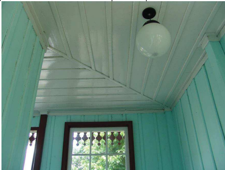
Figura 17 - Detalhe da estrutura – pilares - aparentes internamente.
