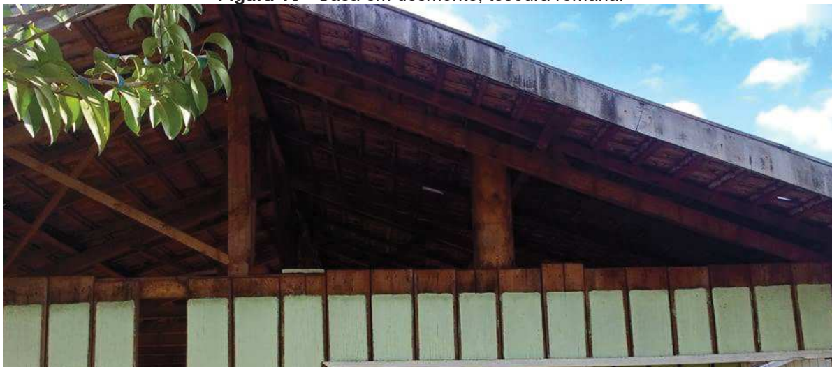
Figura 16 - Casa em desmonte, tesoura romana.
