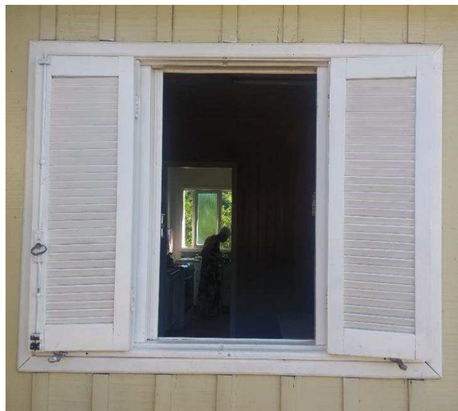
Figura 32 -- a) Casa de tábua e mata-junta em Cascavel – PR, com janelas em madeira e metal. b) Modelo de janela adotada de uma casa de tábua e mata-junta em Capanema – PR.
