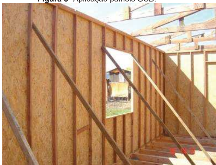
Figura 3- Aplicação painéis OSB.
