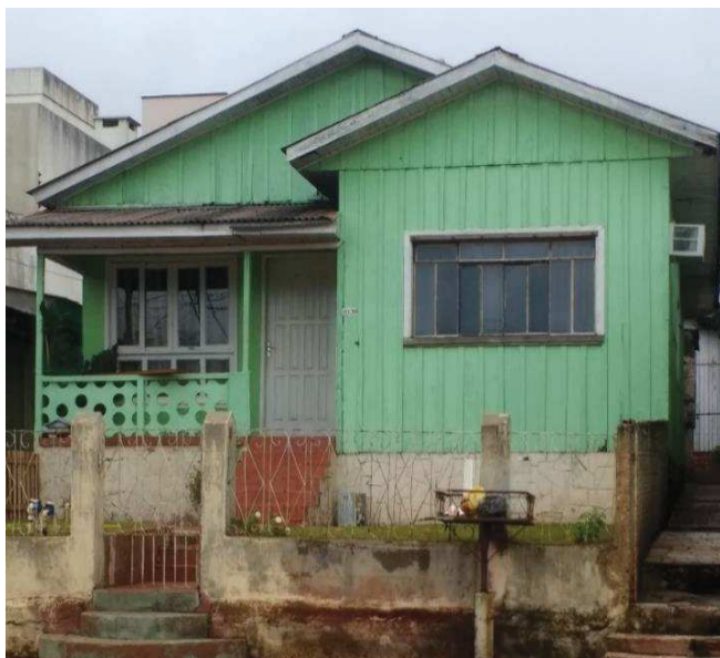
Figura 32 -- a) Casa de tábua e mata-junta em Cascavel – PR, com janelas em madeira e metal. b) Modelo de janela adotada de uma casa de tábua e mata-junta em Capanema – PR.
