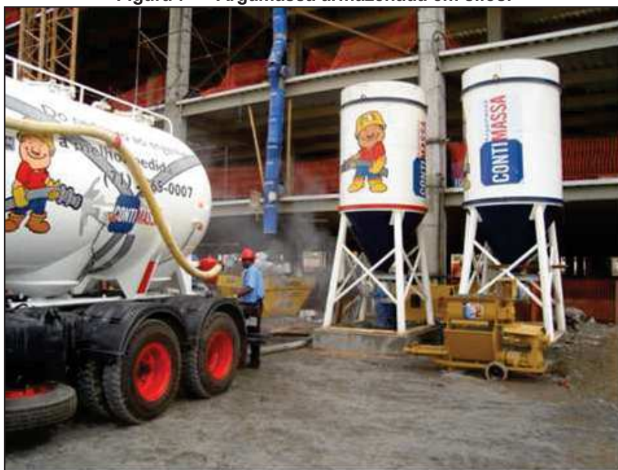
Figura 7 — Argamassa armazenada em silos.
