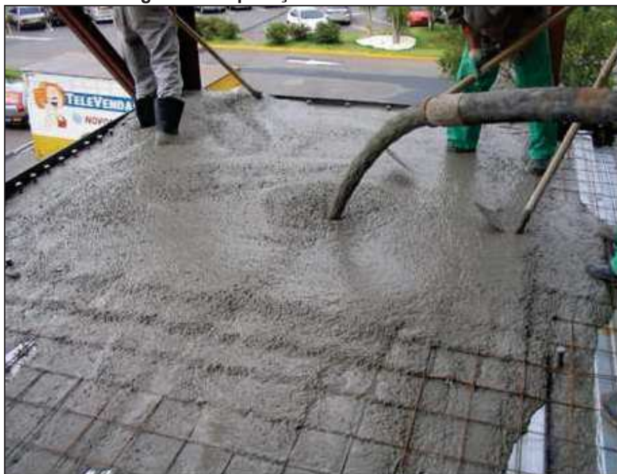
Figura 6 — Aplicação de concreto usinado.
