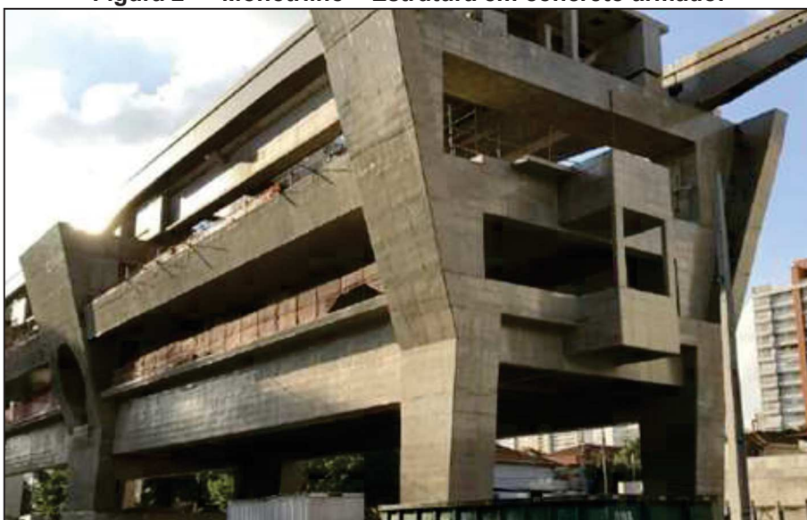
Figura 2 — Monotrilho – Estrutura em concreto armado.
