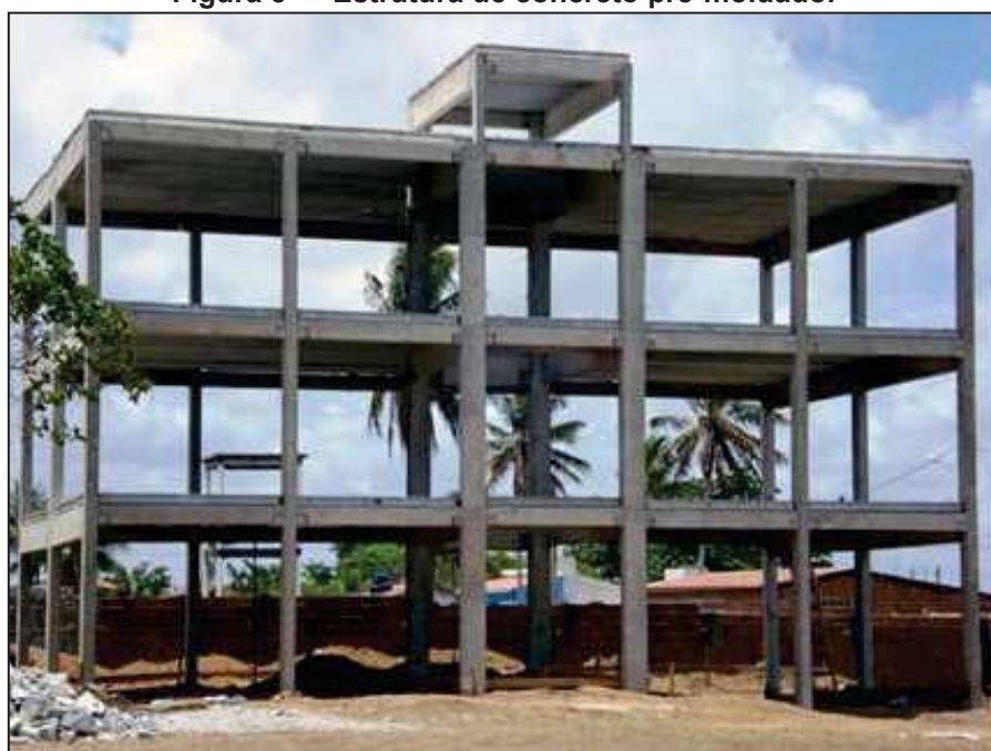
Figura 5 — Estrutura de concreto pré-moldado.
