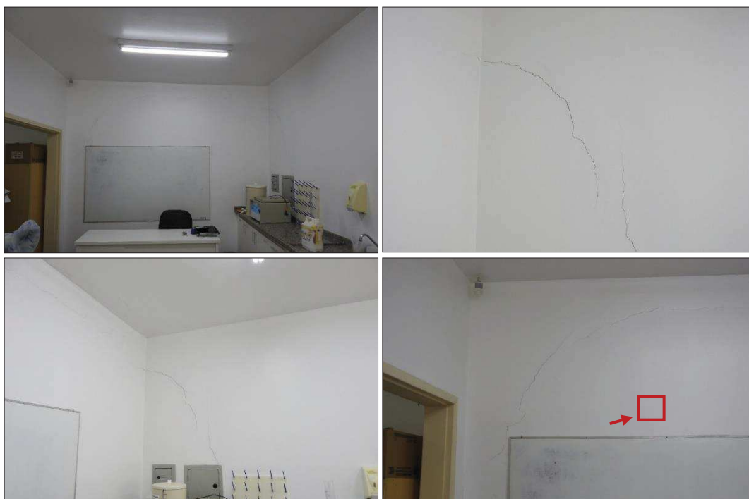
Figura 20 – Recalque diferencial em pilares
