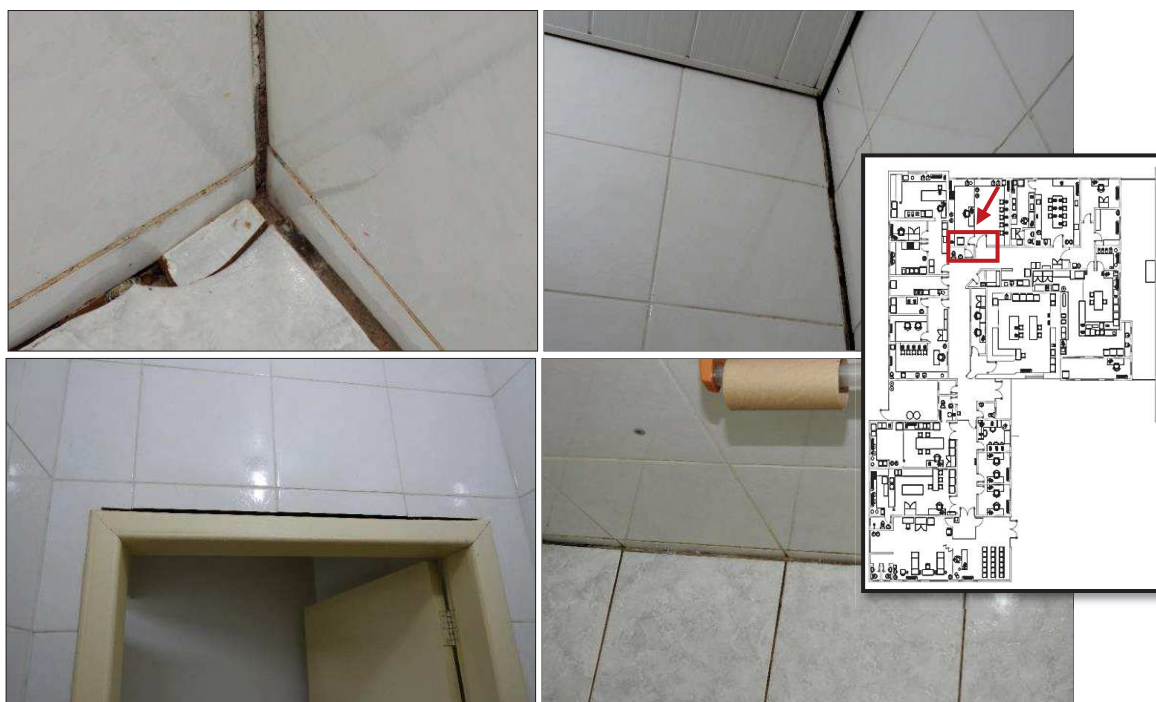
Figura 29 - Deslocamento devido ao adensamento do solo do aterro
