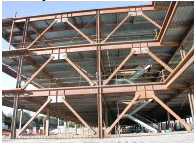
Figura 14: Contraventamento em K
