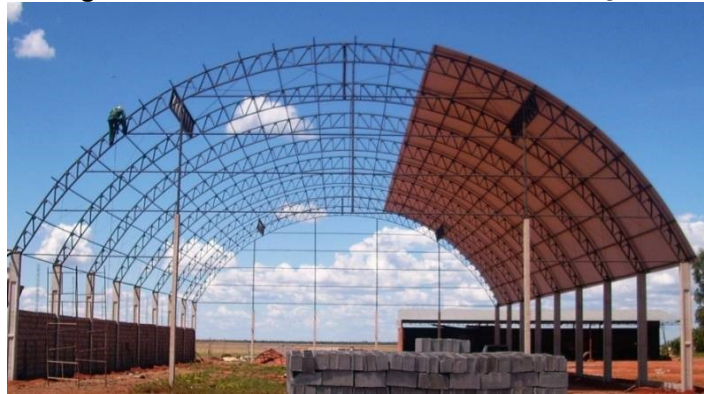
Figura 6: Pórtico em cobertura de arco treliçada
