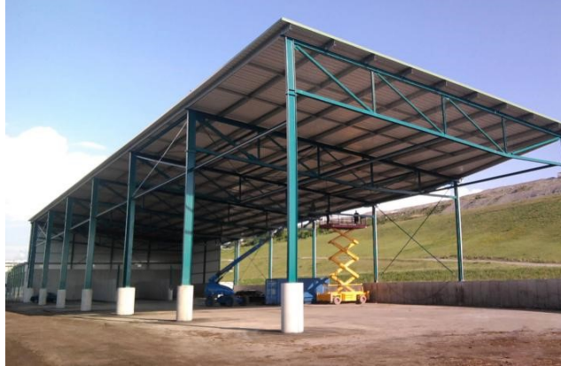
Figura 9: Pórtico com treliça - banzos paralelos
