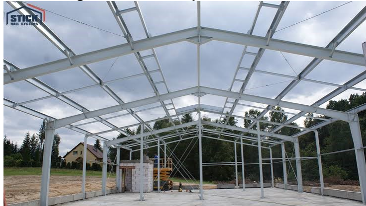
Figura 4 Pórtico simples de alma cheia
