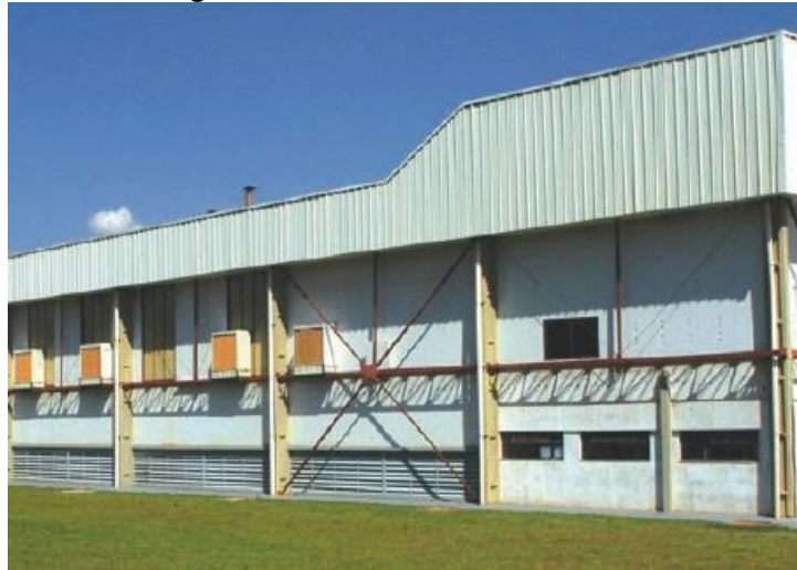
Figura 13: Contraventamento em X
