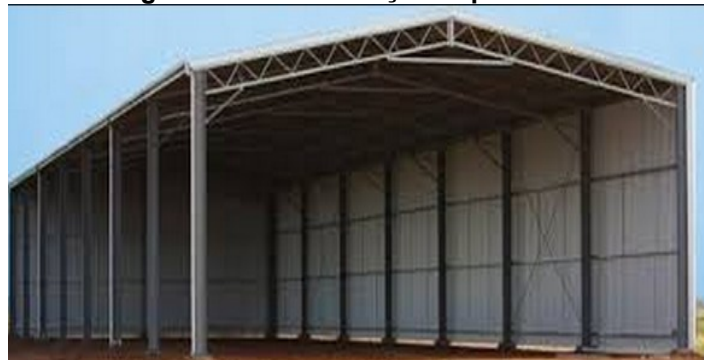
Figura 7: Pórtico treliçado tipo Warren
