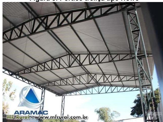
Figura 8: Pórtico treliça tipo Howe
