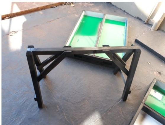
Figura 6: Impermeabilização das formas e cavaletes.
