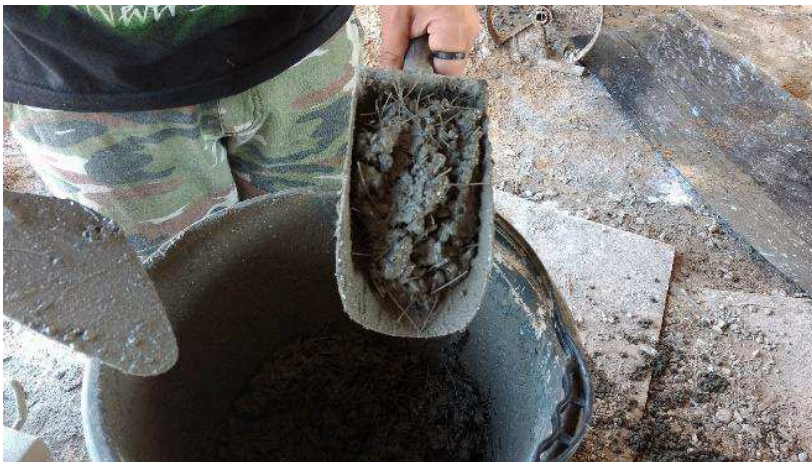
Figura 6 – Concreto com material alternativo.
