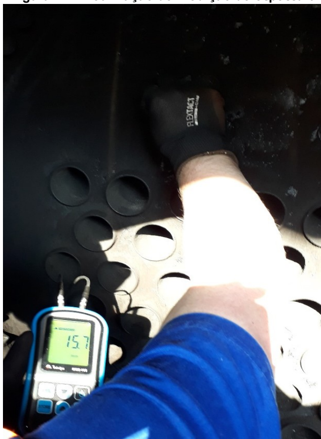
Figura 17 – Realização de medição de espessura
