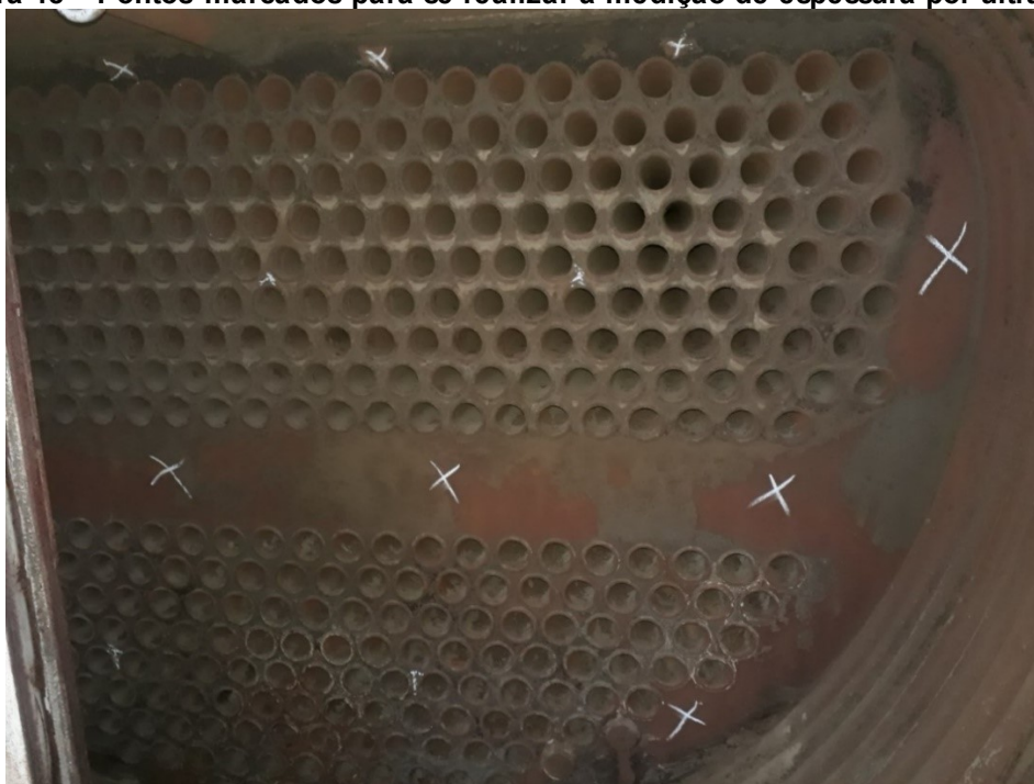
Figura 18 – Pontos marcados para se realizar a medição de espessura por ultrassom
