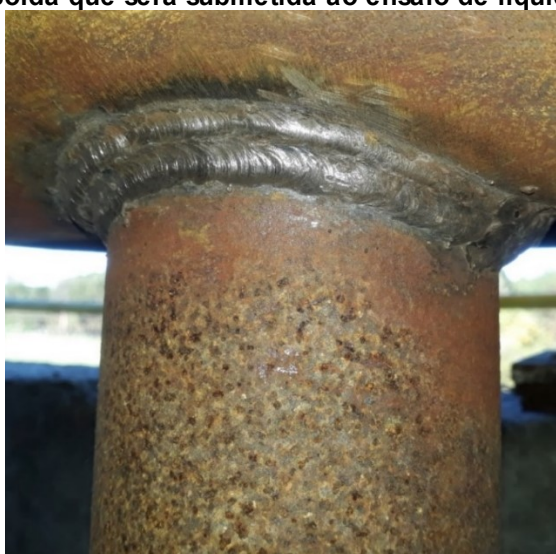
Figura 14 – Solda que será submetida ao ensaio de líquido penetrante
