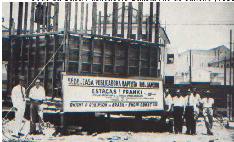
Figura 1 – Prova de carga em estaca tipo Franki executada na Sede da Casa Publicadora Batista Rio de Janeiro (1935)
