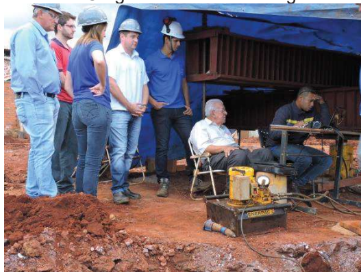
Figura 23 – Prova de Carga Reservatório de Água do SAAE
