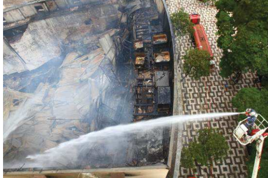
Figura 20 – Incêndio no Teatro
