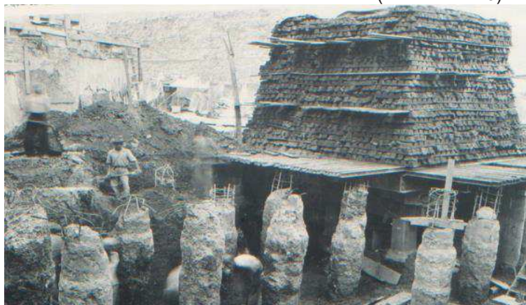
Figura 2 - Prova de carga em estaca tipo Franki executada no Edifício do BANESPA São Paulo (década de 40)
