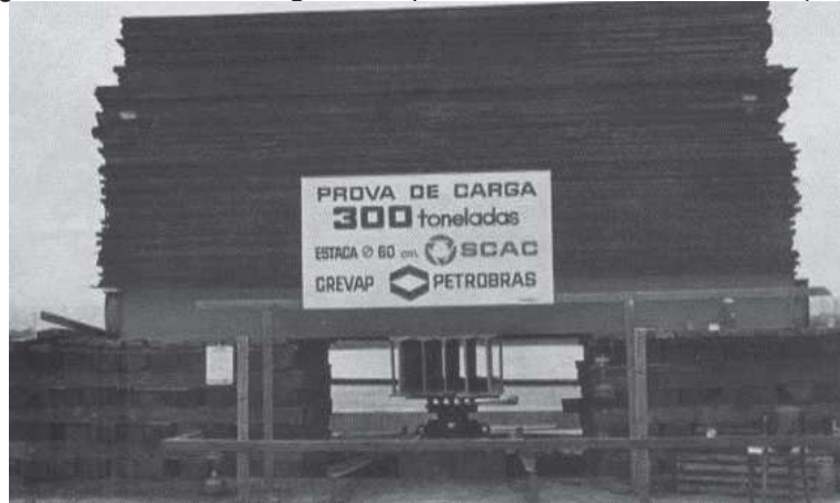
Figura 3 – Prova de Carga à compressão na Ponte Rio-Niterói (1971)
