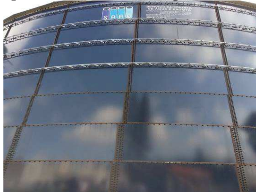
Figura 22 – Reservatório de Água do SAAE
