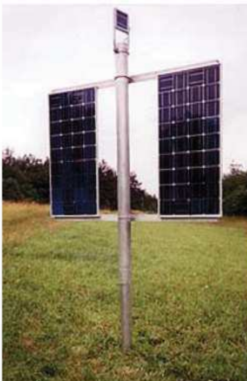
Figura 9 - Rastreador com movimentação no eixo azimute
