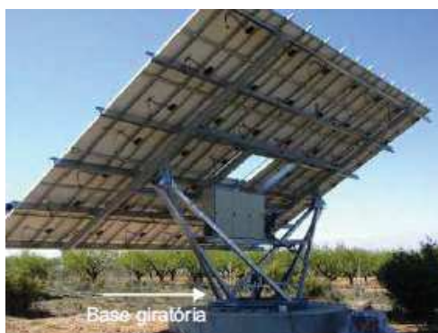
Figura 13 - Estrutura com plataforma giratória
