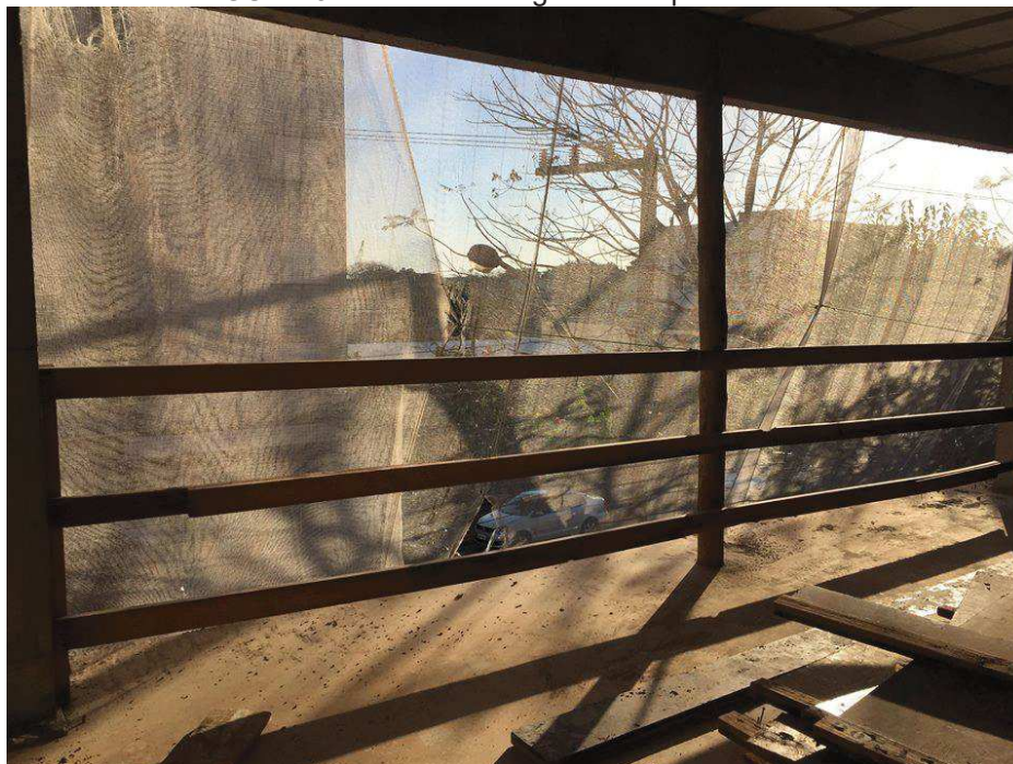
FIGURA 37 – Sistema de guarda corpo.
