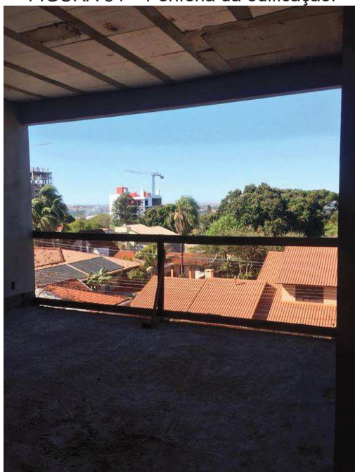
FIGURA 54 – Periferia da edificação.
