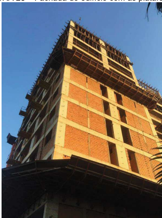
FIGURA 23 – Fachada do edifício com as plataformas.
