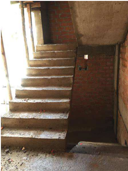
FIGURA 58 – Escada de uso coletivo.
