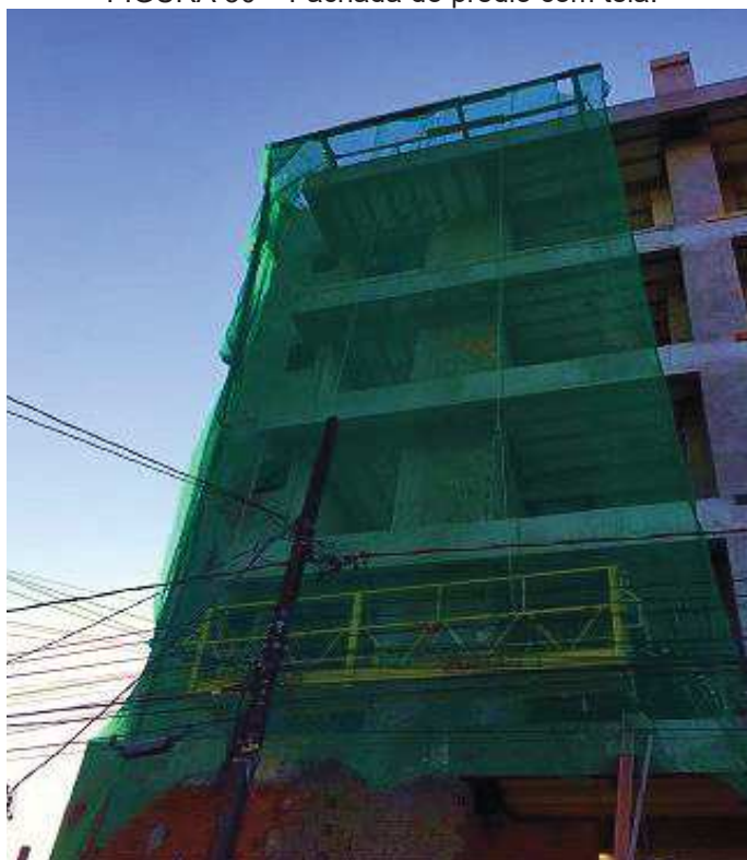
FIGURA 30 – Fachada do prédio com tela.
