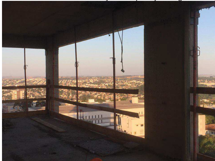
FIGURA 20 – Periferia da edificação com proteção de guarda corpo.
