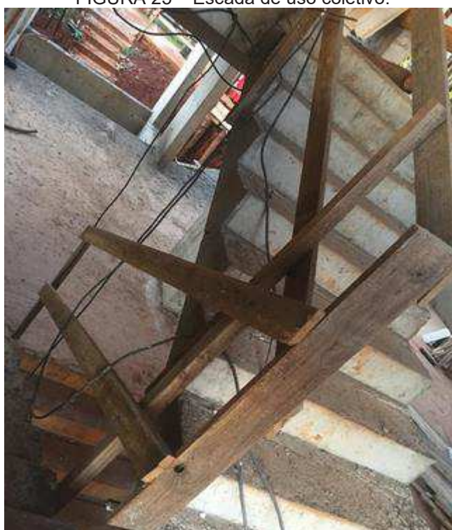
FIGURA 25 – Escada de uso coletivo.
