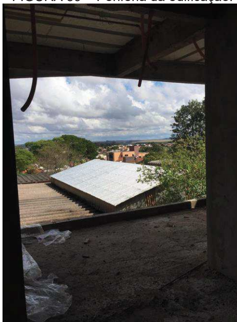
FIGURA 59 – Periferia da edificação.
