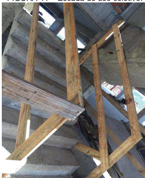
FIGURA 41 – Escada de uso coletivo.
