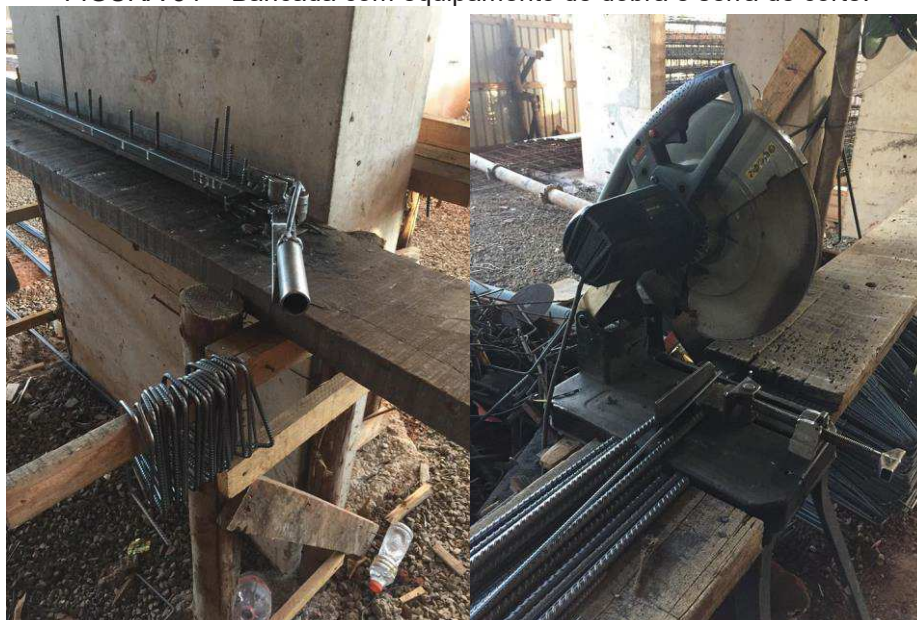
FIGURA 34 – Bancada com equipamento de dobra e serra de corte.
