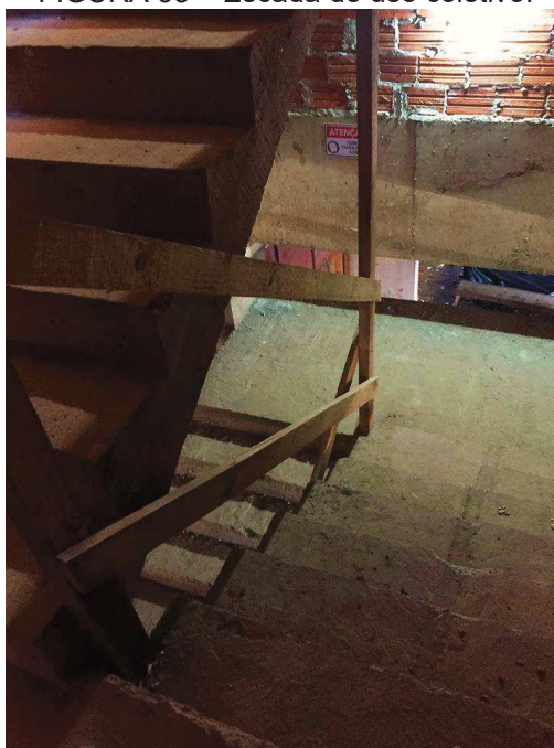
FIGURA 35 – Escada de uso coletivo.
