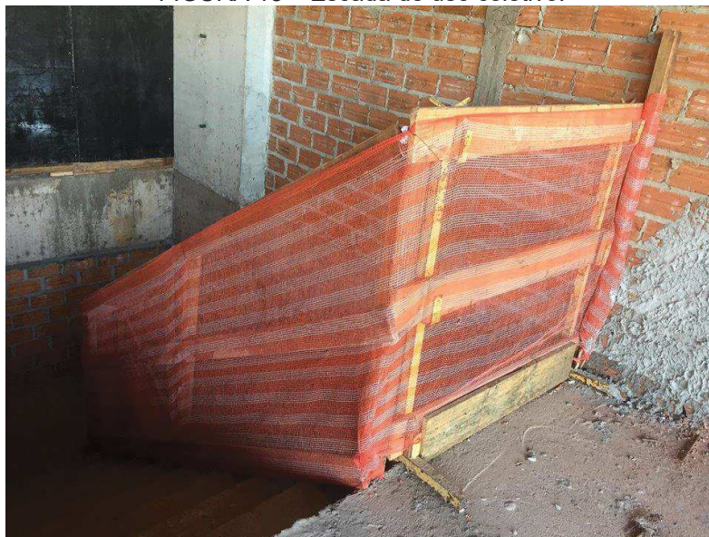
FIGURA 18 – Escada de uso coletivo.
