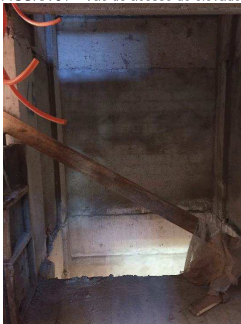
FIGURA 51 – Vão de acesso do elevador.
