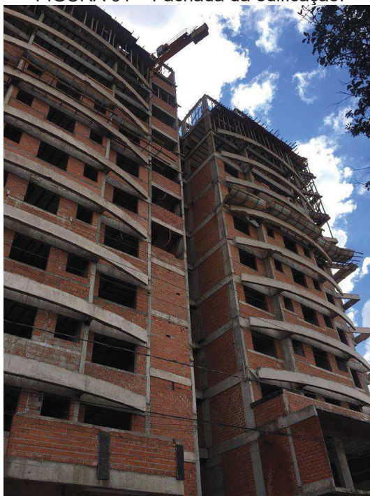
FIGURA 61 – Fachada da edificação.
