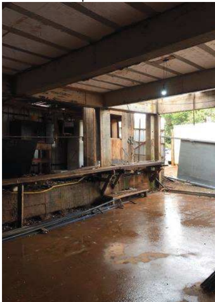
FIGURA 57 – Bancada para corte e dobra de vergalhões.
