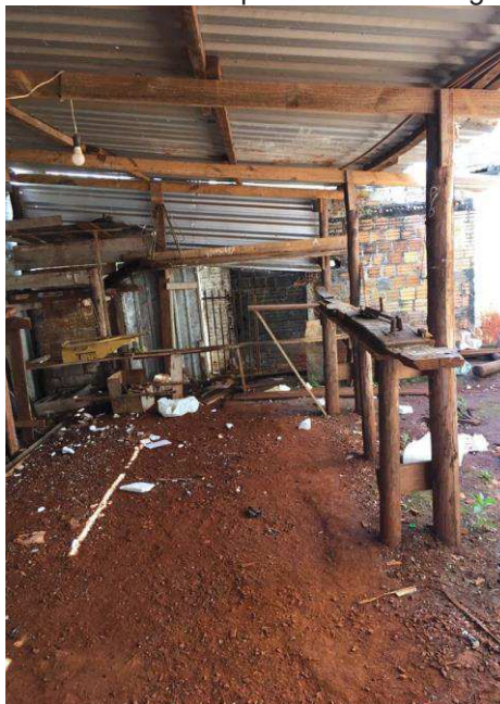
FIGURA 49 – Bancada para dobra de vergalhões.
