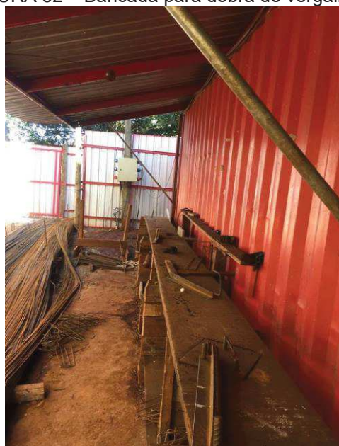
FIGURA 52 – Bancada para dobra de vergalhões.
