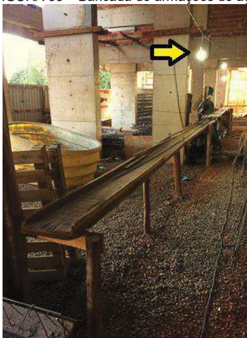
FIGURA 33 – Bancada de armações de aço.
