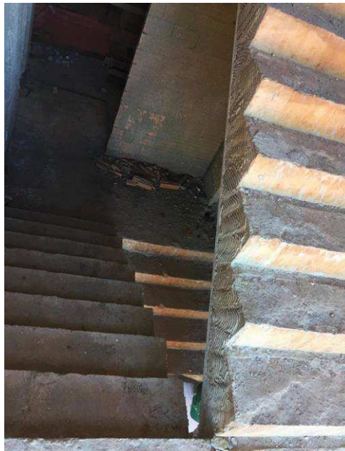
FIGURA 53 – Escada de uso coletivo.
