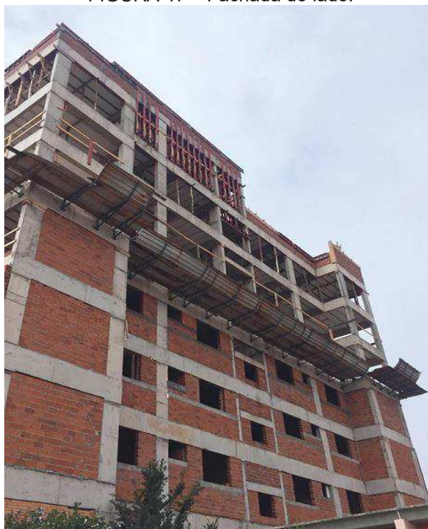
FIGURA 47 – Fachada do lado.
