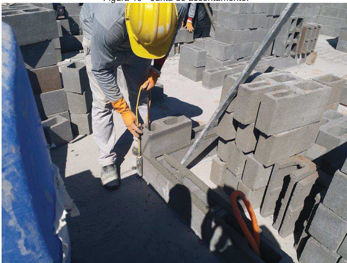
Figura 19 - Junta de assentamento.
