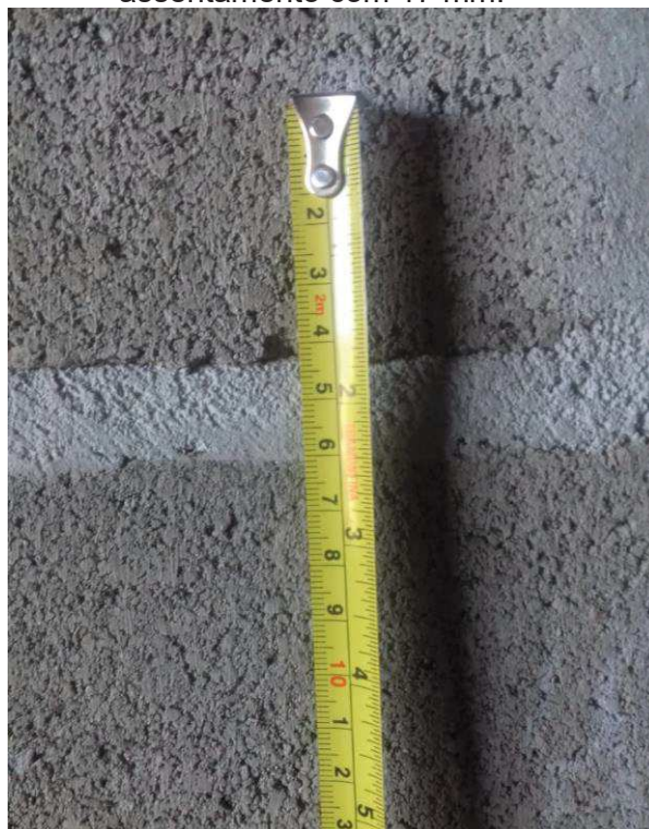
Figura 21 - Junta horizontal de assentamento com 17 mm.
