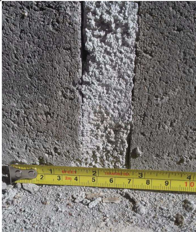
Figura 23 - Junta vertical de assentamento com 28 mm.
