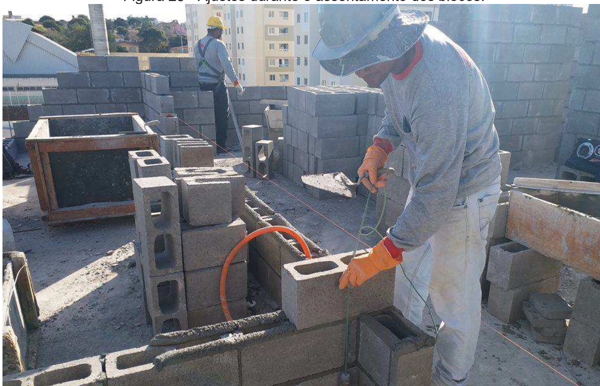
Figura 25 - Ajustes durante o assentamento dos blocos.
