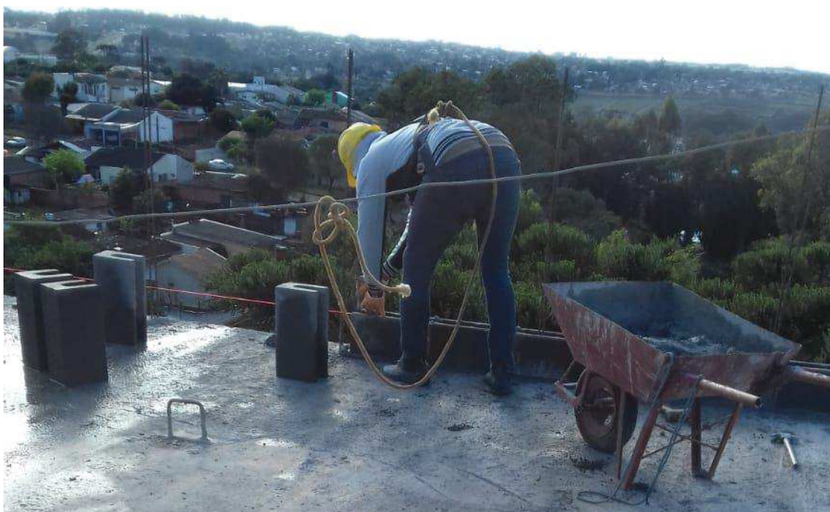
Figura 17 - Uso de fios flexíveis no assentamento dos blocos.
