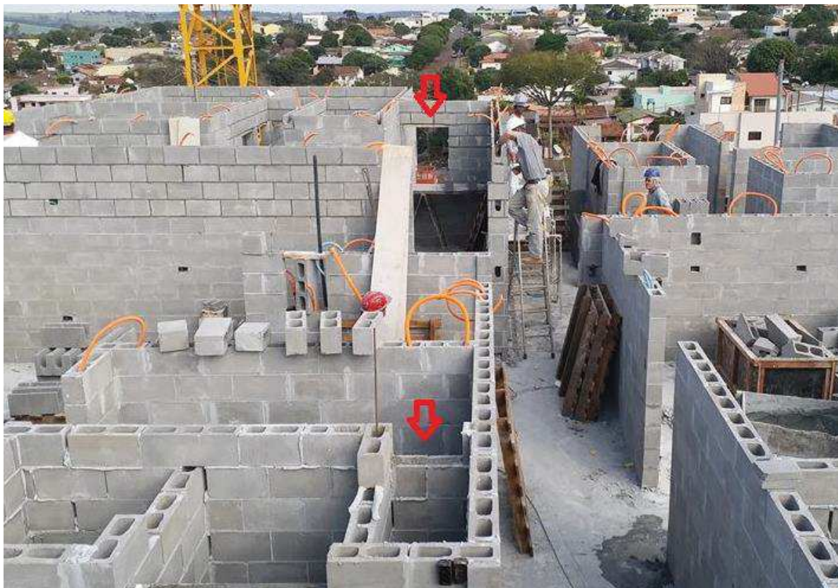
Figura 16 - Vergas e contravergas sem os 30 cm mínimos de blocos canaletas para cada lado da abertura.
