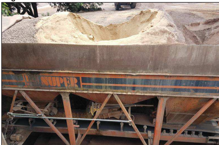
Figura 38 — Silos frios da usina de Asfalto de Toledo – PR
