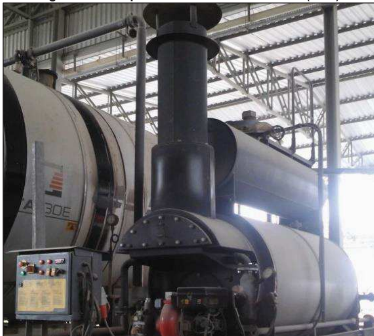
Figura 23 — Aquecedor de Fluido Térmico (AFT)
