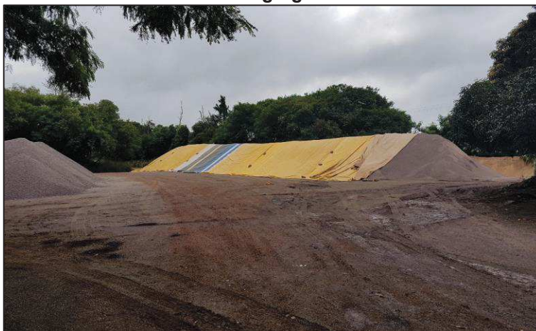
Figura 34 — Pátio de armazenamento de agregados na usina de asfalto de Toledo – PR
