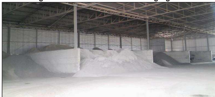
Figura 22 — Armazenamento de agregados
