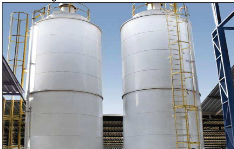
Figura 28 — Silos de inclusão de finos
