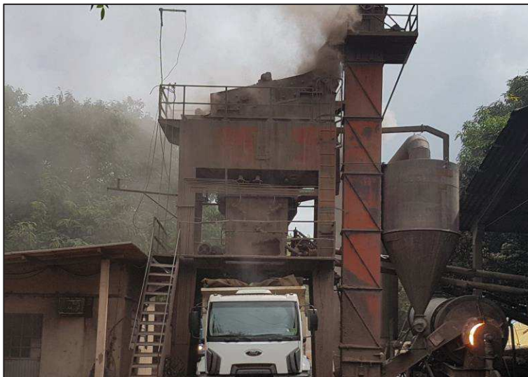
Figura 43 — Torre Gravimétrica da Usina de Asfalto de Toledo – PR
