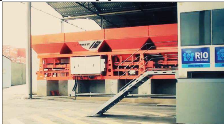
Figura 24 — Silos frios de agregados da Usina de Antônio Ramos
