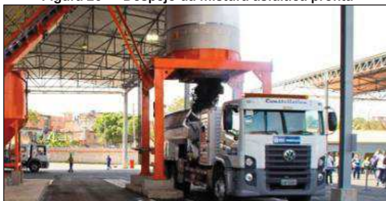
Figura 26 — Despejo da mistura asfáltica pronta
