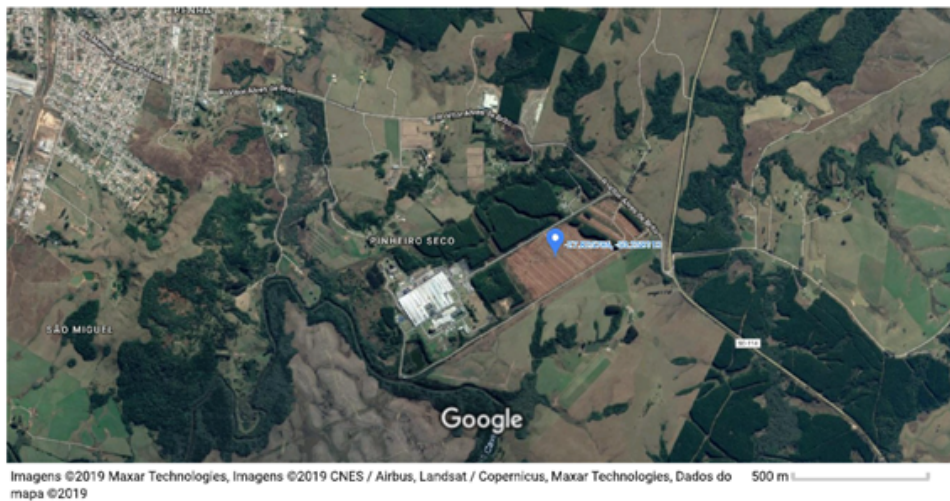
Figura 25 – Local de instalação da usina fotovoltaica.
