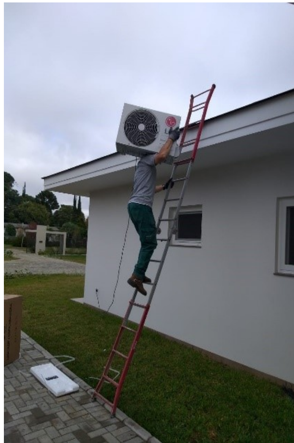
Figura 3 - Instalador com ar condicionado
