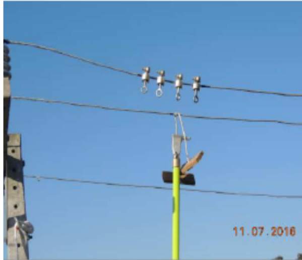
Figura 7 - Remoção de objeto estranho da rede MT.
