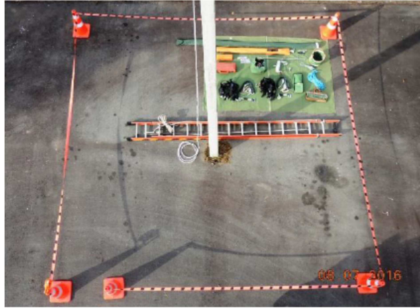
Figura 1 - Adaptação da área de trabalho e inspeção de ferramentas, materiais e equipamentos na arena.
