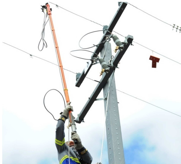
Figura 3 - Instalação de conjunto de aterramento temporário para MT.
