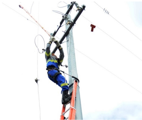
Figura 5 - Remoção de conjunto de aterramento temporário para MT.
