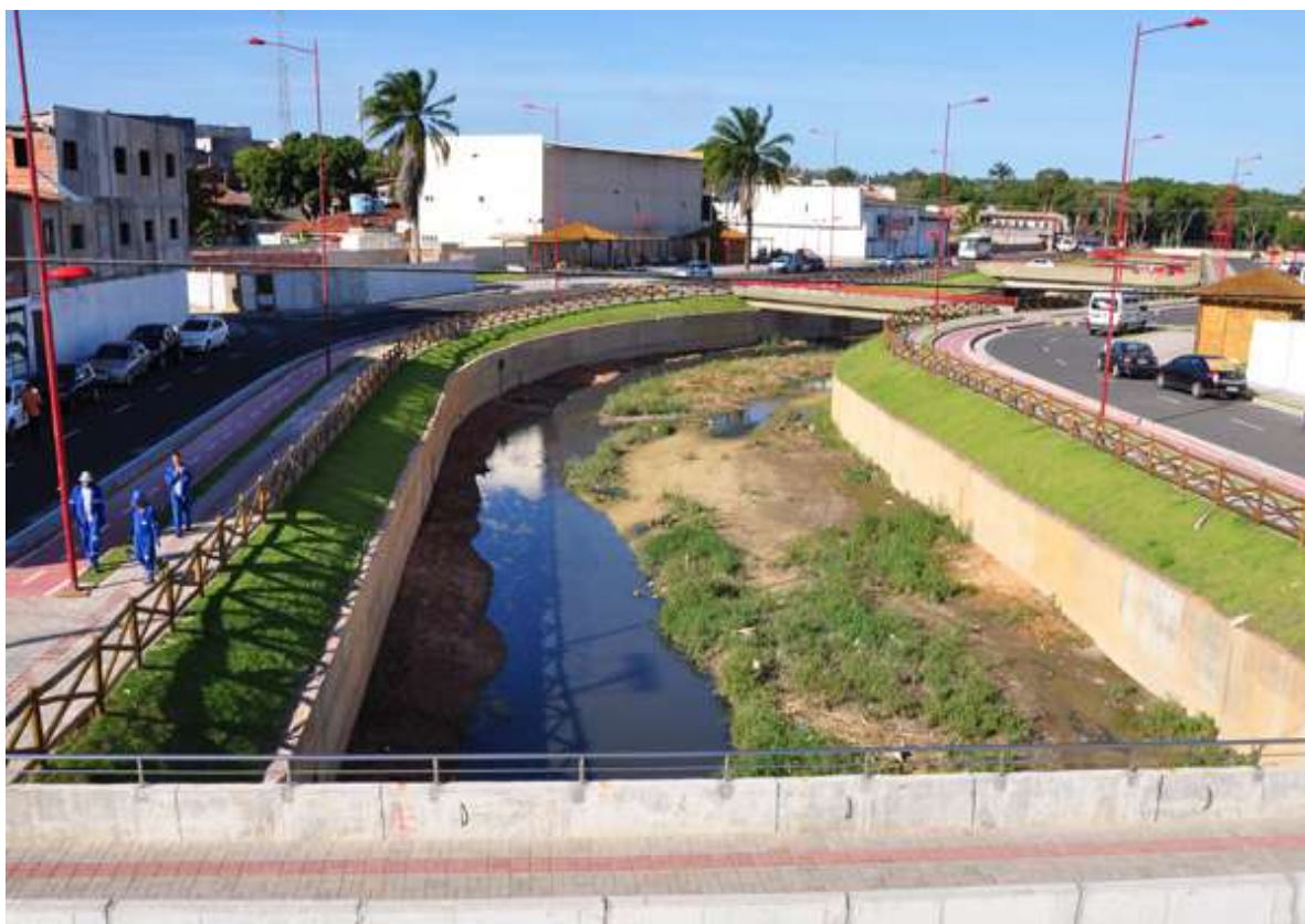
Figura 8. Imagem do Rio Camaçari mostrando assoreamento, crescimento de mato e resíduos sólidos em parte do canal. Fonte: Santos, (2018).
