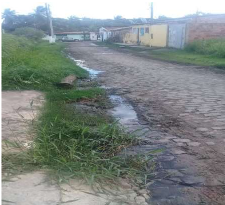
Figura 11. Flagrantes de plantas invasoras crescendo no espaço da rede de drenagem Fonte: Autoria Própria
