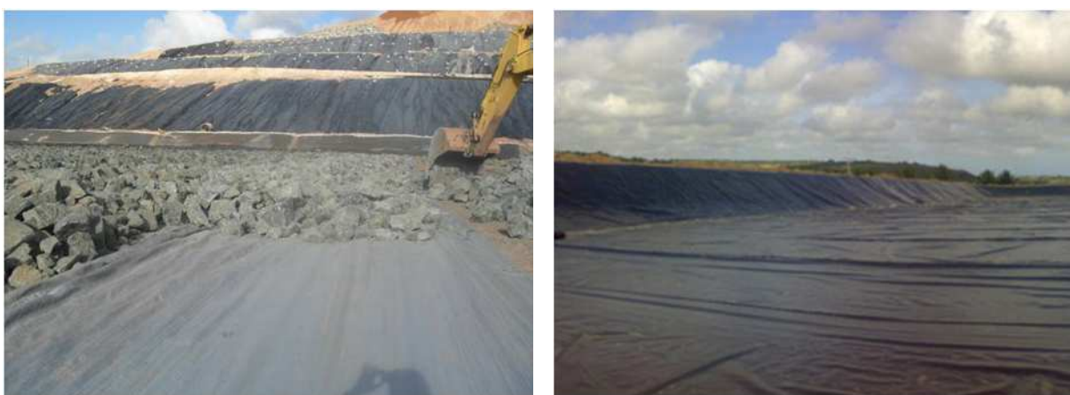
Figura 3 – Camadas de Impermeabilização da célula com Geomembrana e manta de PEAD Fonte: A autora (2012).
