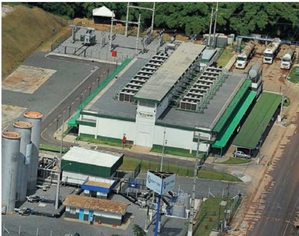
Figura 11 – Vista aérea da Usina Termoverde Salvador (BA) Fonte: Solvi (2012).
