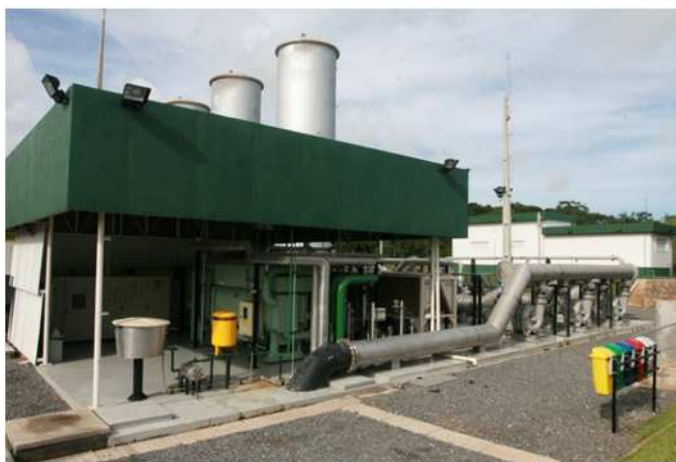
Figura 9 – Central de processamento dos gases (filtração, compressão, etc) Fonte: Foto de Rafael Martins/AGECOM (2014).
