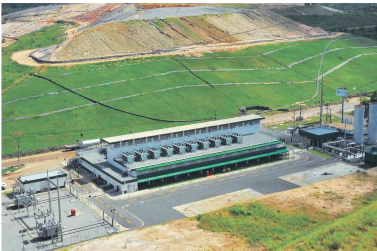
Figura 10 – Vista do Aterro Sanitário Metropolitano de Salvador e da usina Termoverde Fonte: Solvi (2011).
