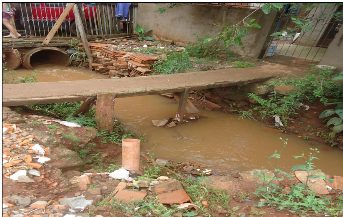
Figura 2: Casas construídas as margens do rio.
