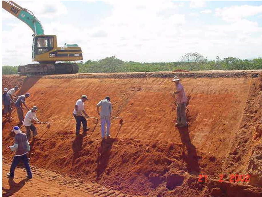
Figura 2 – Acabamento Manual em Talude de Aterro Fonte: Terraplenagem.net (2013).
