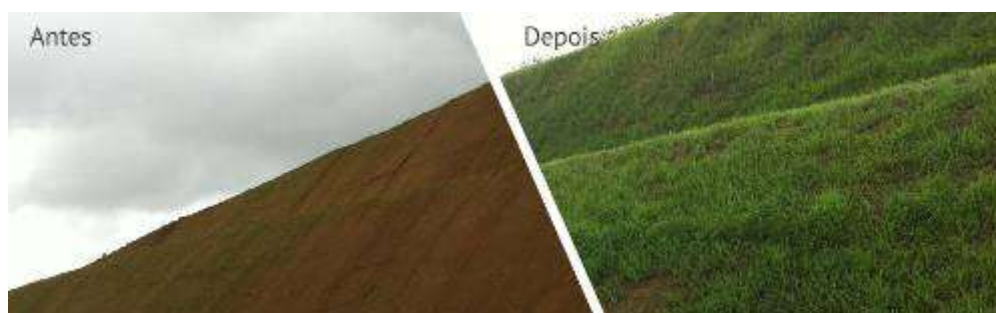
Figura 10 – Talude de Corte Revegetado Com o Uso de Biomanta de Fibra de Coco na BA 535 (Via Parafuso) Fonte: Fibraztech (2013).
