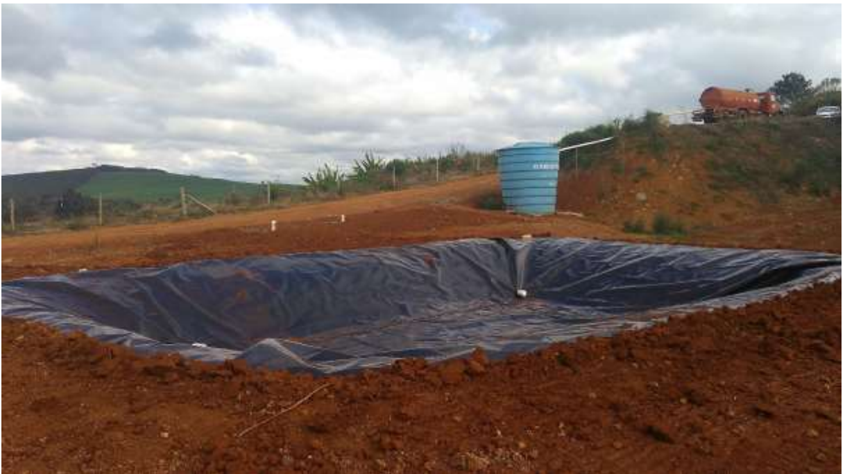
Figura 188 – Lagoa Wetlands Com Lona PEAD Instalada 02 Fonte: Própria
