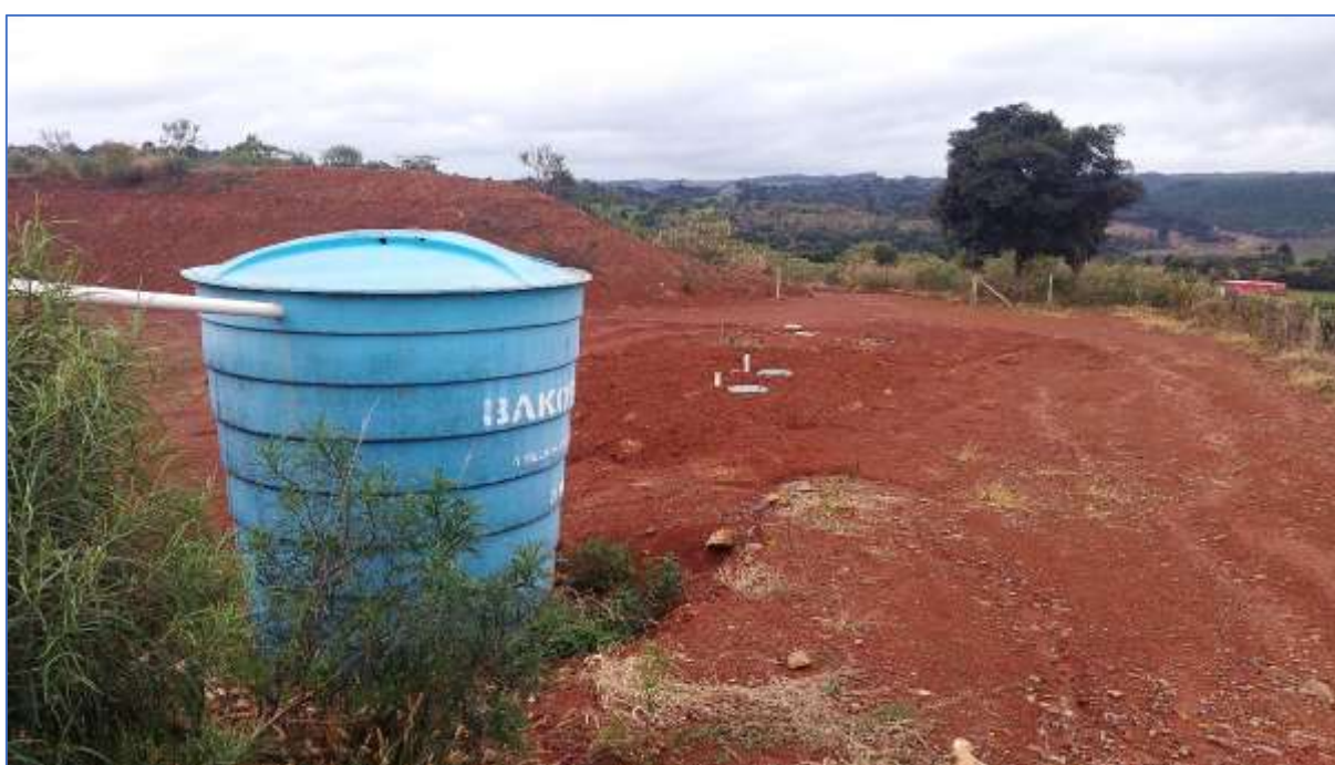
Figura 6 - Tanque de Armazenamento de Esgoto Fonte: Própria
