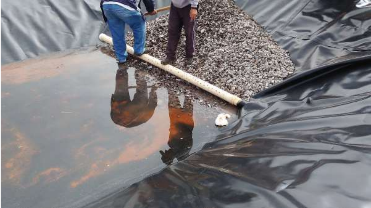
Figura 199 – Lagoa Wetlands Instalação da Tubulação de Entrada e Saída do Esgoto Fonte: Própria
