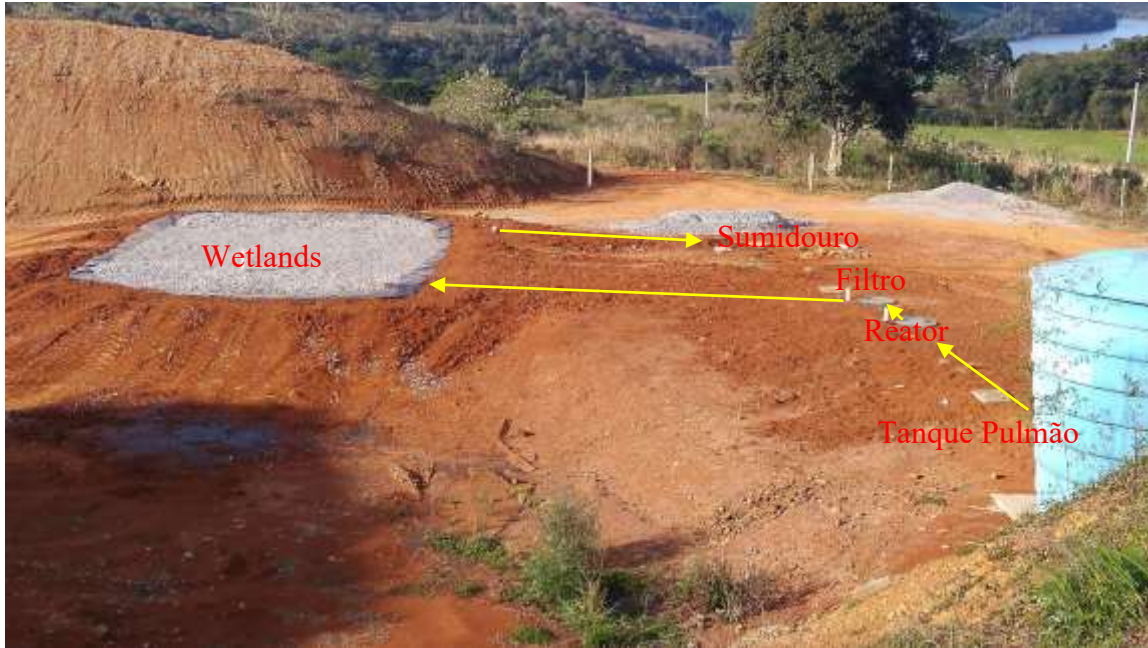
Figura 211 – Conceção Final Após a Instalação da Wetlands Fonte: Própria
