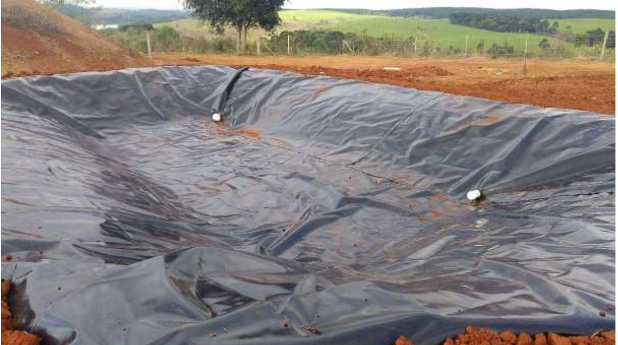
Figura 177 – Lagoa Wetlands Com Lona PEAD Instalada 01 Fonte: Própria
