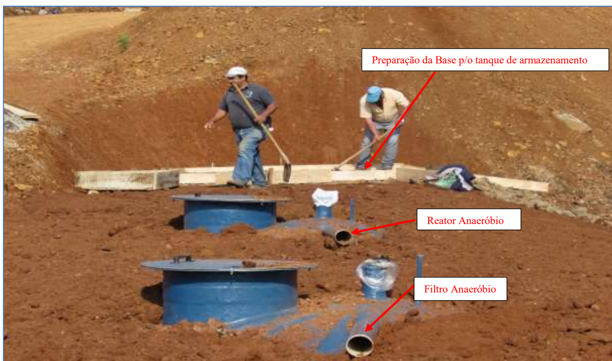
Figura 7 - Instalação dos Tanques Para o Tratamento (Dezembro/2017)
