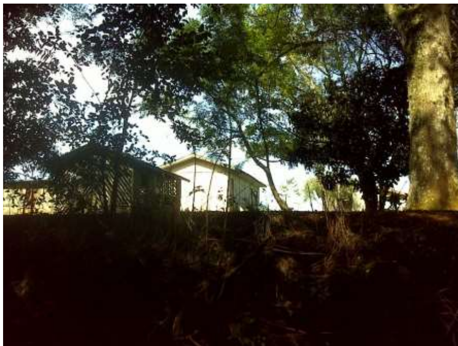
Figura 13. Edificações Localizadas Dentro da Área de Preservação Permanente do Rio Cascavel.
