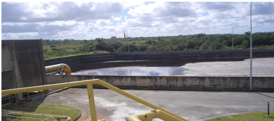
Figura 7: Tanque de emergência
