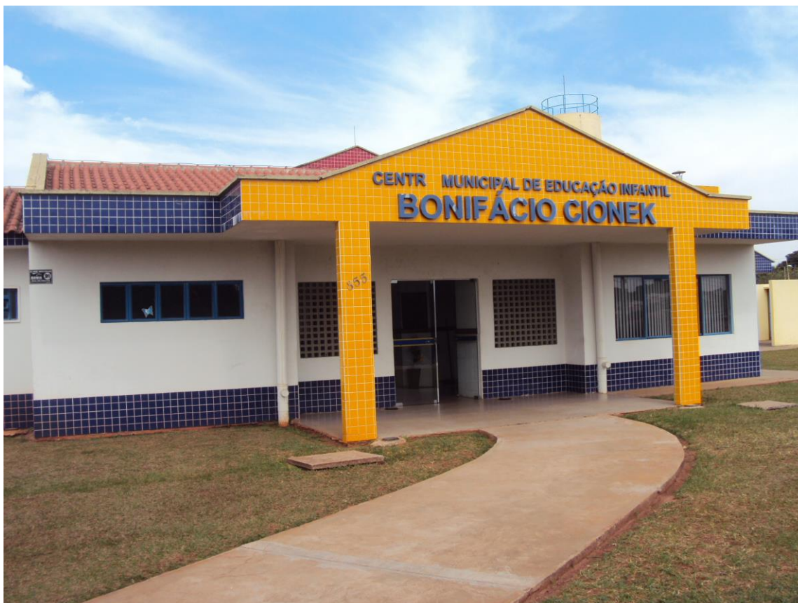
Figura 2: Fachada do CMEI
