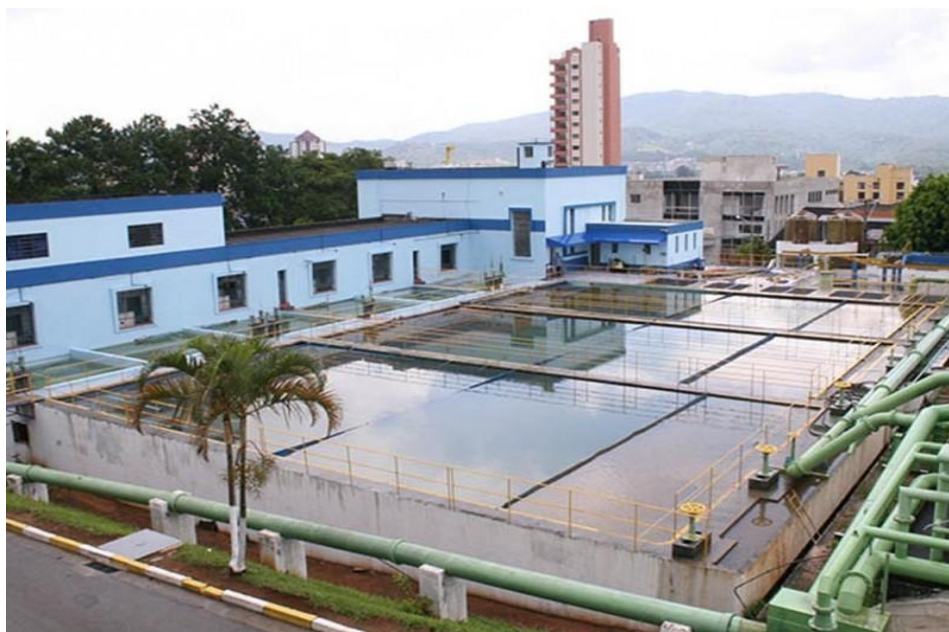
Figura 3 - Vista da ETA Centro
