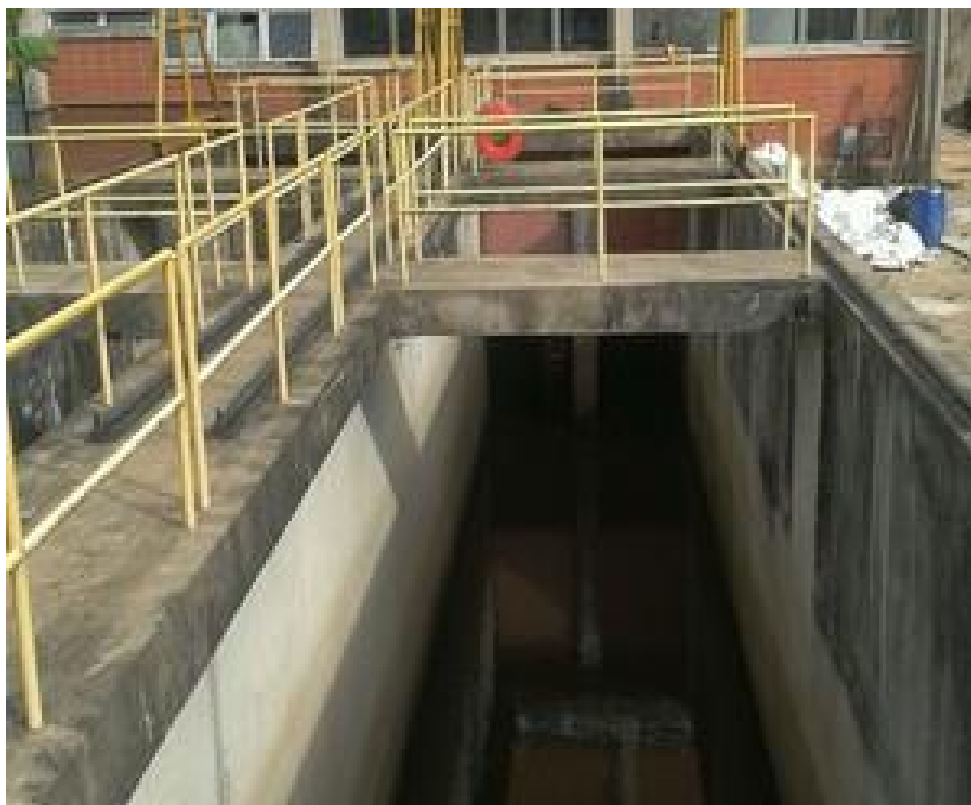
Figura 2 - Vista da entrada de água na captação ECR II
