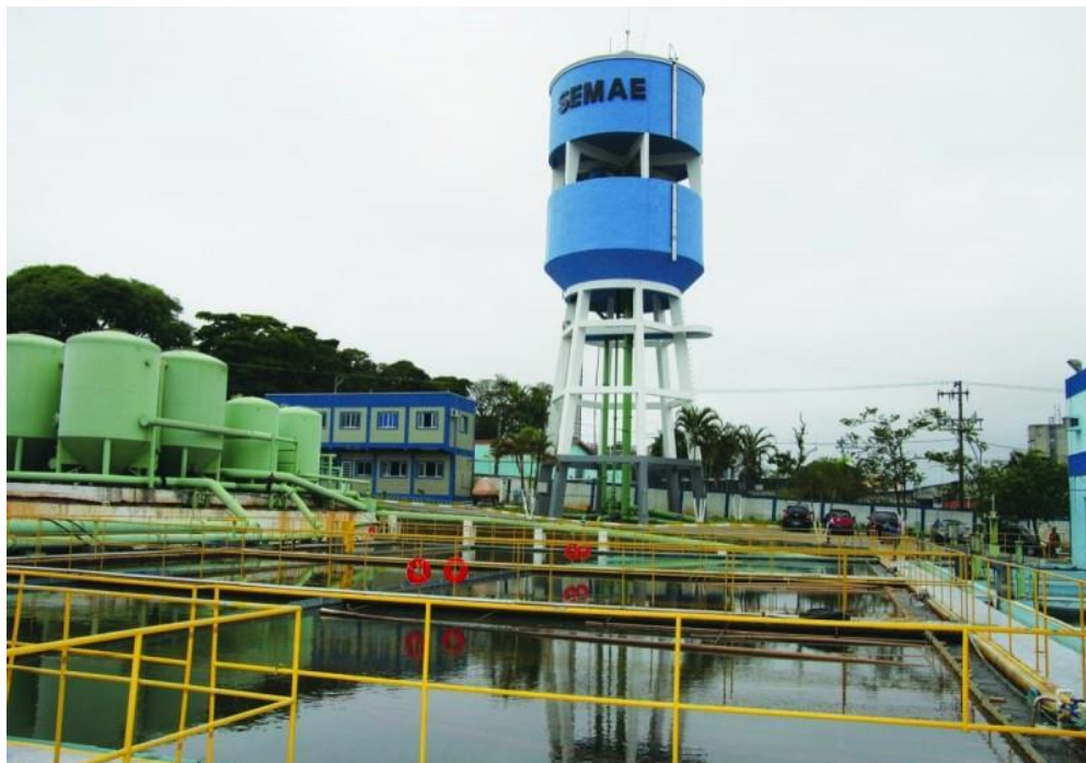
Figura 5 - Ao fundo uma das torres usadas como reservatório de água Foto: PMMC. (2016)
