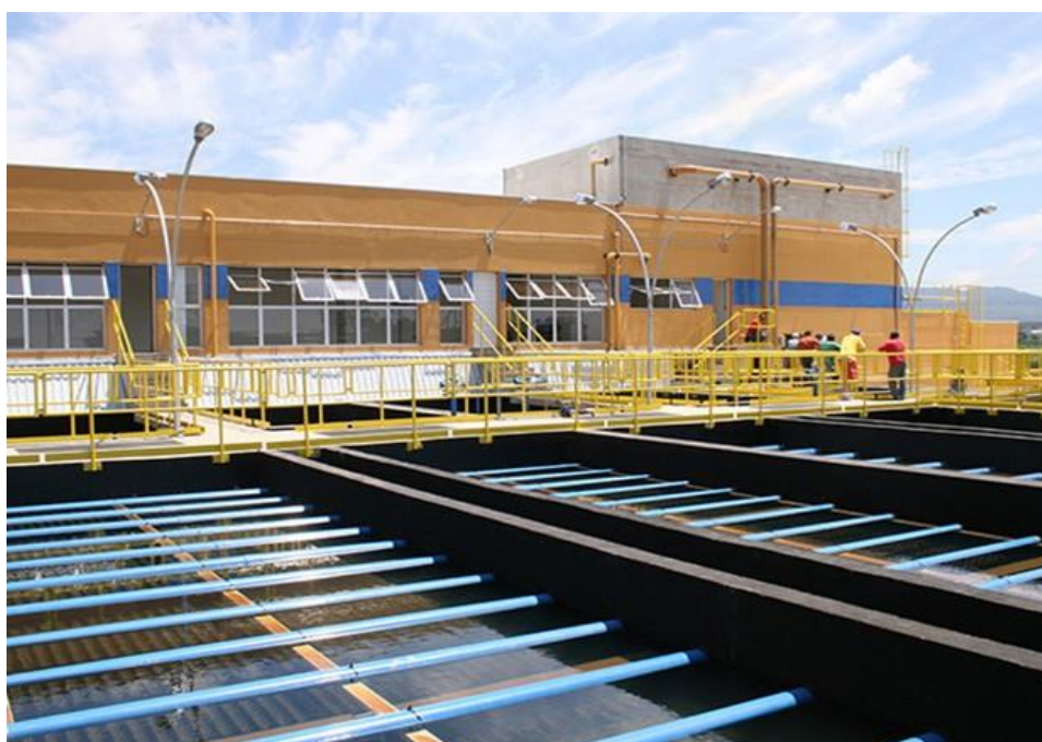
Figura – 4 Vista da ETA LESTE
