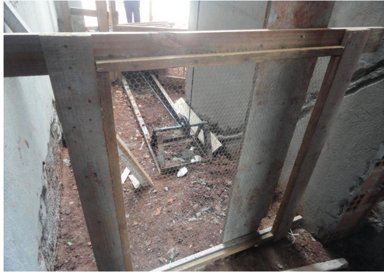
Fotografia 2: Cabo e roldana livre sem proteção.
