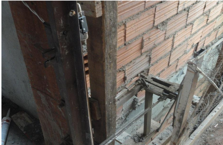
Fotografia 5: Dispositivo eletromecânico de travamento da cancela
