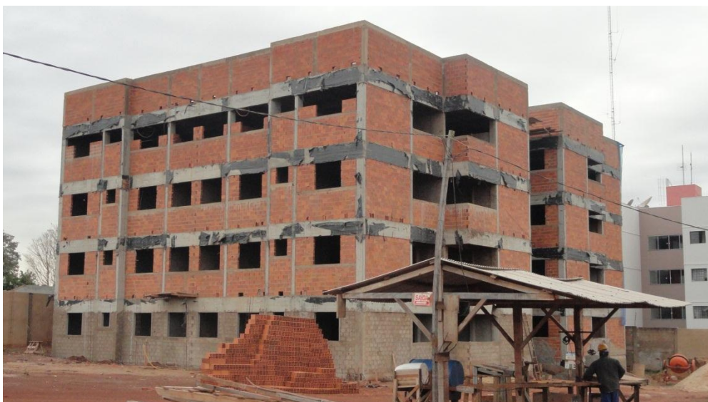
Fotografia 1: Canteiro de obras do empreendimento
