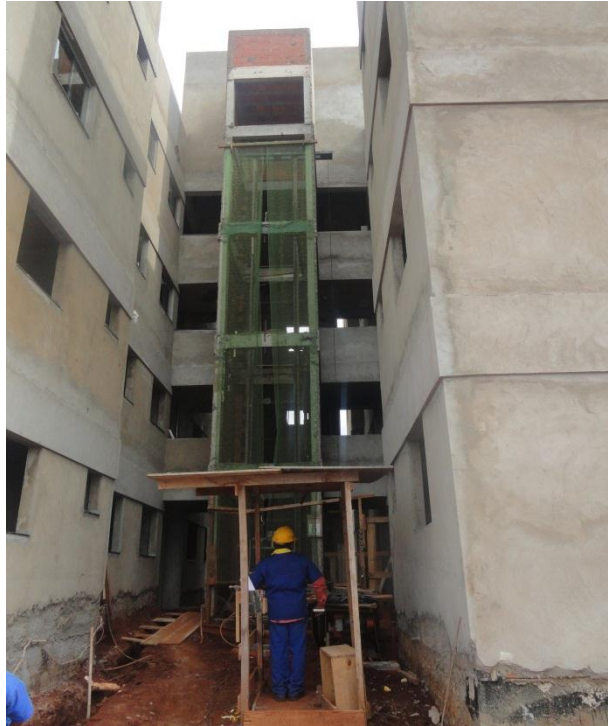
Fotografia 4: Visão Geral do Elevador de materiais.
