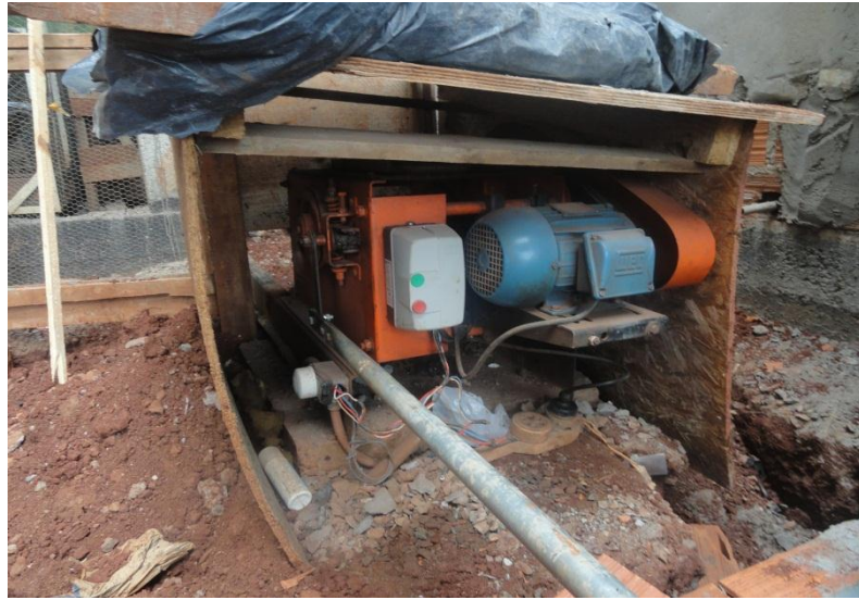
Fotografia 8: Instalação do guincho "bate-estaca" do elevador de materiais.
