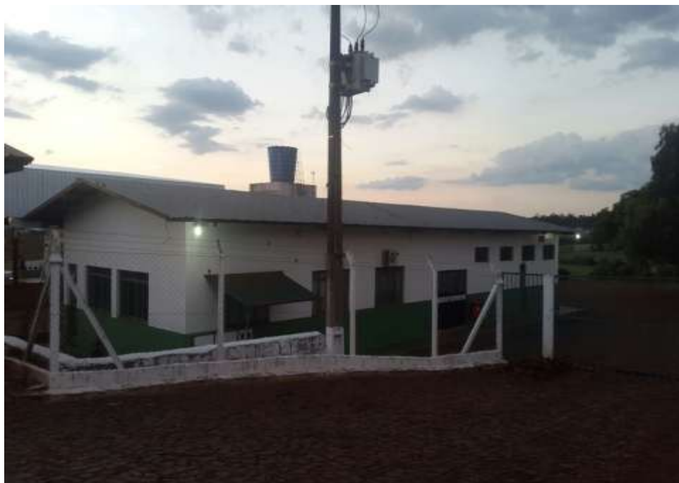
Figura 2: Instalações externas do Frigorífico. Fonte: Autoria Própria (2018)
