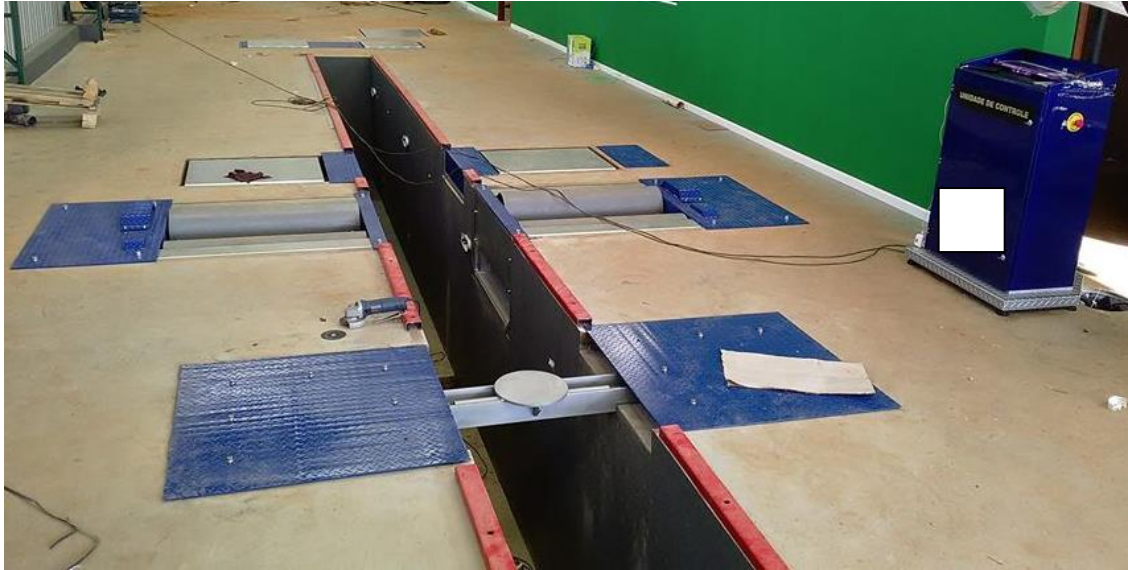
Figura 1 – Linha de inspeção veicular Fonte: Próprio autor
