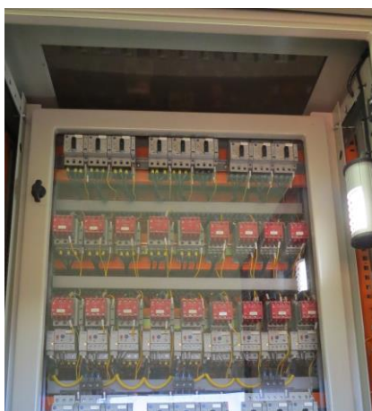
Figura 34 - Porta do CCM com várias partidas que utilizam dois contatores em série Fonte: O autor (2016)
