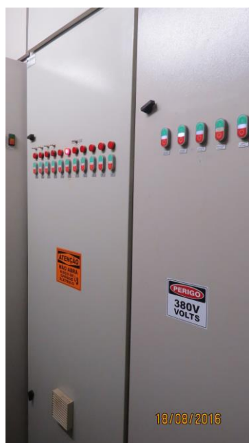
Figura 38 - CCM antigo: botões no painel Fonte: O autor (2016)
