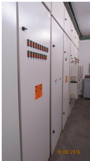
Figura 37 - Foto de um CCM antigo ainda utilizado Fonte: O autor (2016)
