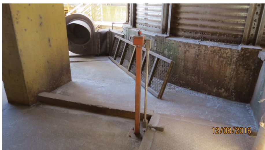
Figura 31 - Botão de emergência setorial Fonte: O autor (2016)
