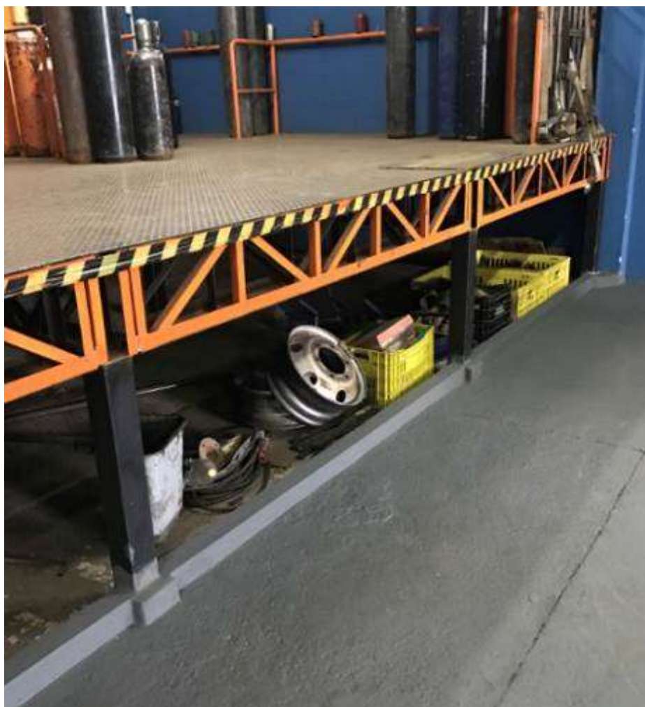
Figura 14 – Itens inflamáveis dispostos em baixo da plataforma. Fonte: Autoria Própria.
