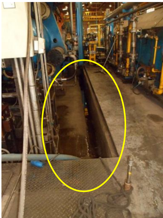
Fotografia 25 – Parte Traseira do Conjunto Prensa: Fosso de 1,5 metros
