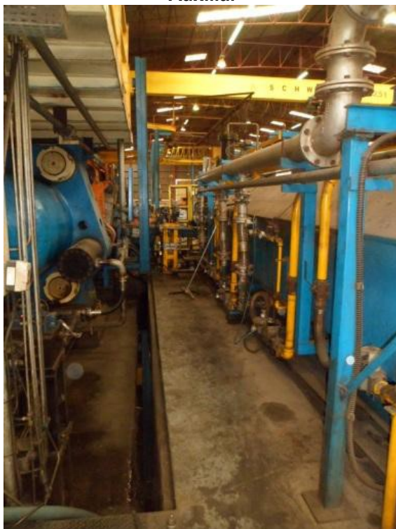
Fotografia 14 – Ambiente Interno da Prensa: Acesso pela Parte Traseira
