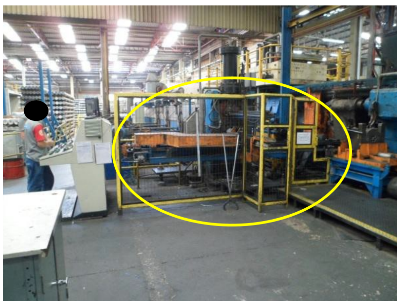
Fotografia 4 – Área de Prensagem com Proteção Fixa Lateral (Tela) Precária
