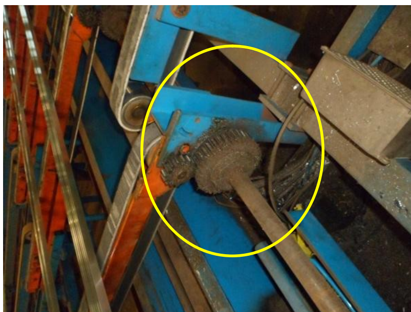
Fotografia 40 – Vista Lateral da Plataforma de Apoio de Perfis: Zona de Risco e Partes Expostas (B)
