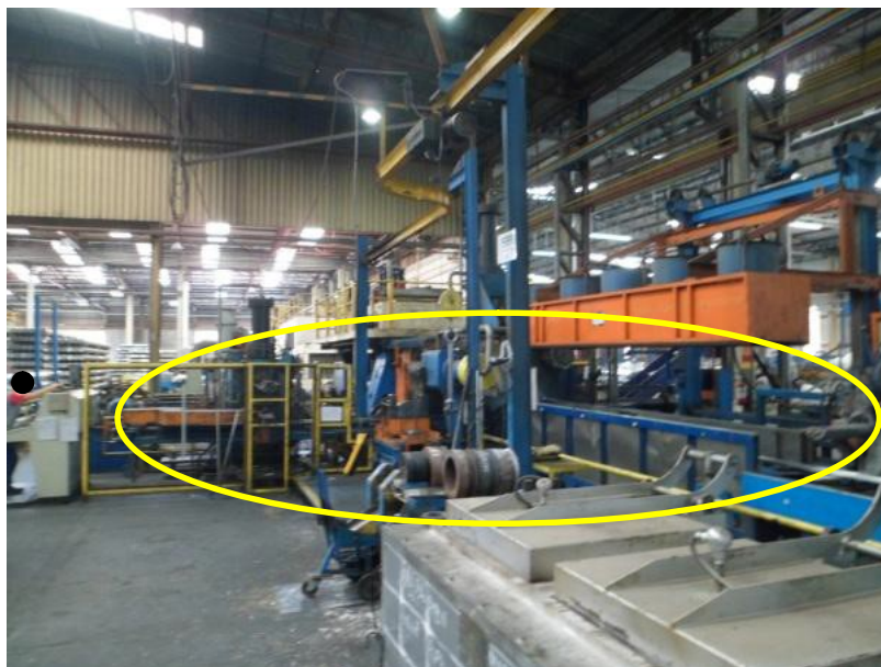
Fotografia 1 – Entorno da Prensa Extrusora: Movimento de Ferramentas Pesadas e Quentes e Ausência de Sinalização
