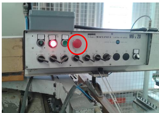
Fotografia 9- Painel de controle com botao de emergencia atual
