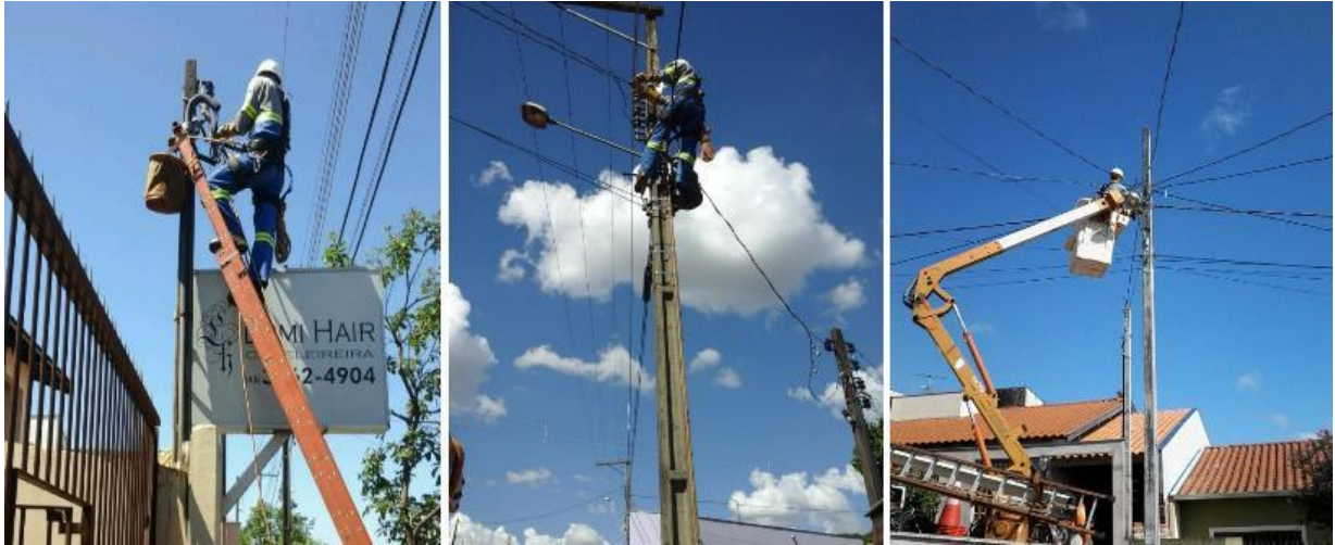
Figura 2- Uso escada, espora e hidroelevador
