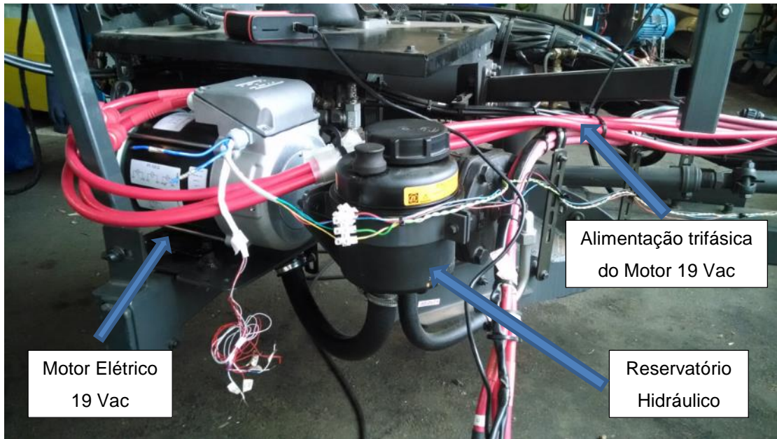
Figura 18 – Instalação do motor elétrico e reservatório hidráulico Fonte: Autor, 2015.
