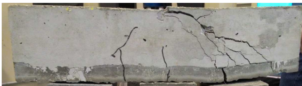
Figura 23 – Alt. 5 – V3 - CPR na região de tração sem ponte de aderência em resina sintética
