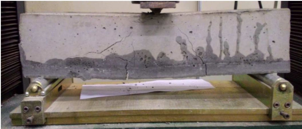
Figura 17 – Alt. 3 – V2 - CPR na região de compressão com ponte de aderência em resina sintética Fonte: Autoria própria
