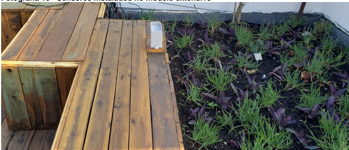
Fotografia 16 - Sensores instalados no modelo extensivo
