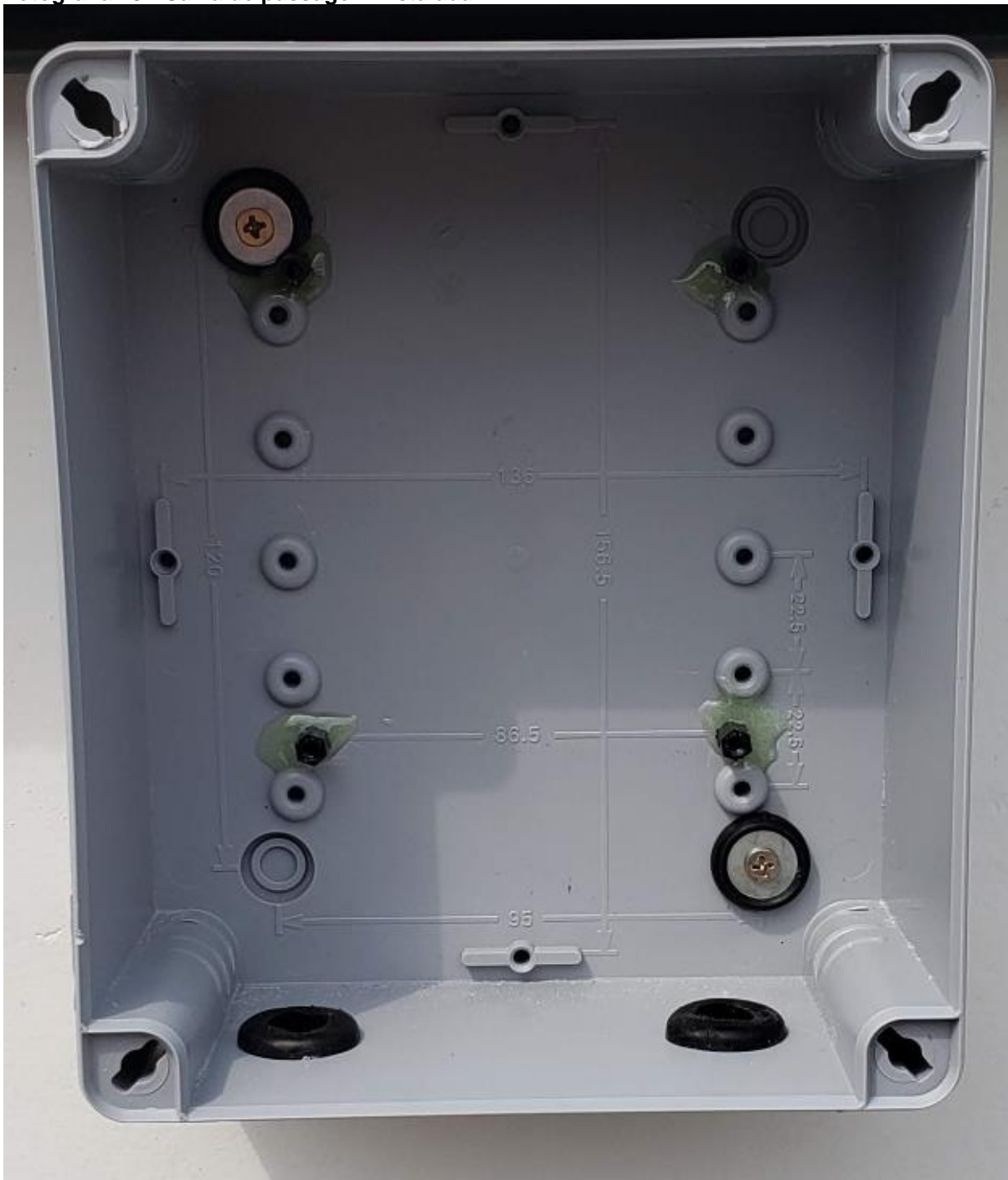
Fotografia 13 - Caixa de passagem instalada
