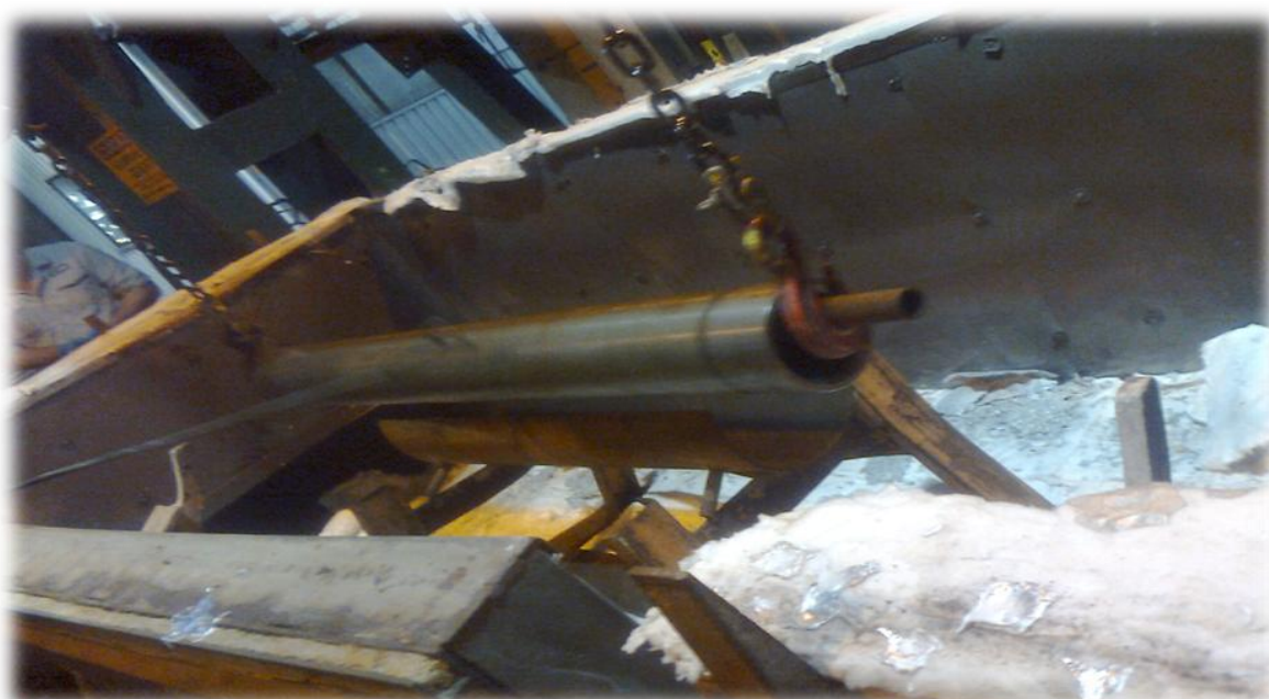
Figura 72 - Tubo sofrendo dilatação para montagem
