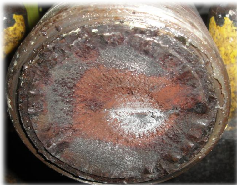
Figura 3 - Falha na ponteira tracionadora
