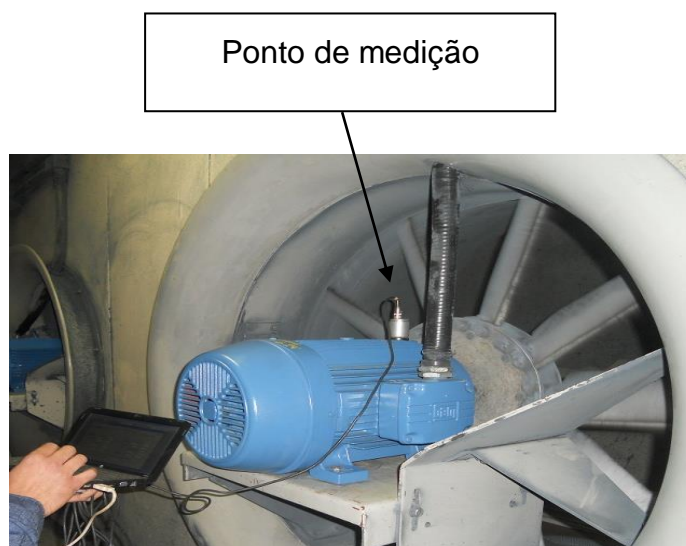
Figura 7: Pontos de Medição de Vibração – Fonte http://www.balaceajato.com.br/fotos_imagens/dscn2447260614184001.jpg
