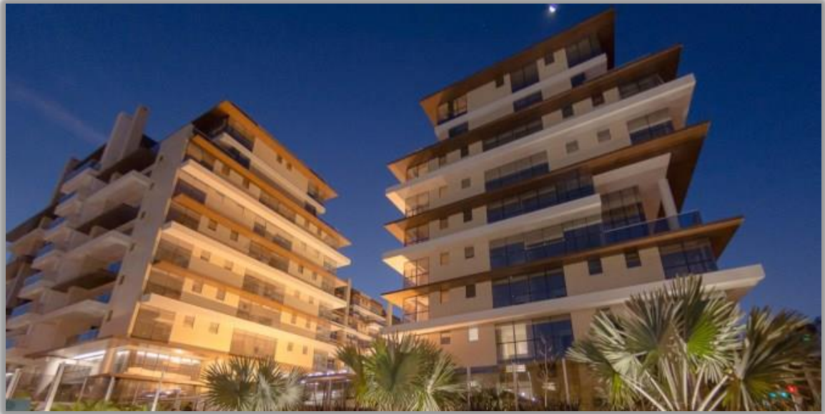
Figura 05 – Fachada do Residencial C
