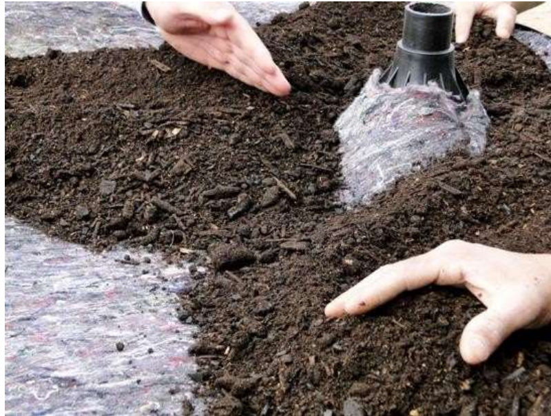
Figura 11- Execução do substrato
