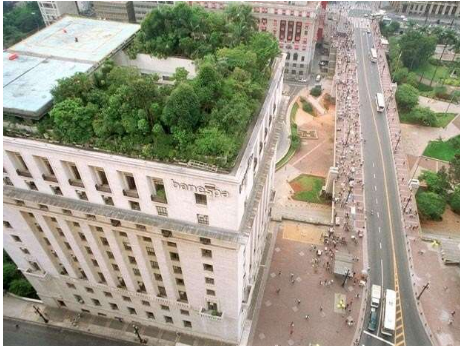
Figura 16- Telhado verde construído no edifício Matarazzo
