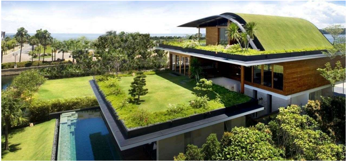
Figura 12- Jardim de cobertura
