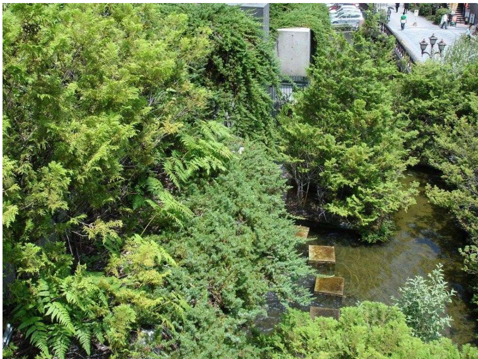
Figura 23- Terraço verde do edifício com área de lazer
