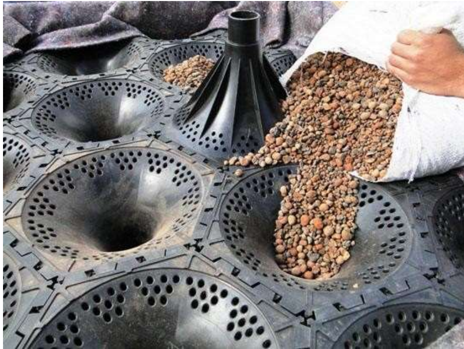
Figura 10- Camada drenante sendo preenchida com cascalho para reter água pluvial
