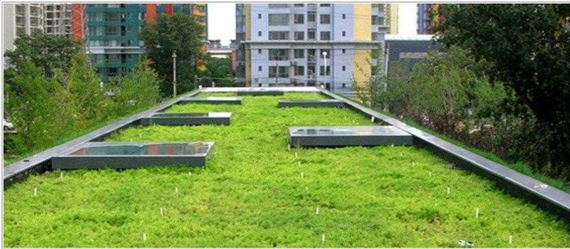
Figura 08- Telhado verde extensivo
