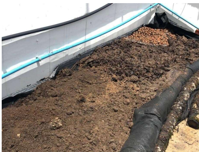
Figura 28- Espalhamento do substrato
