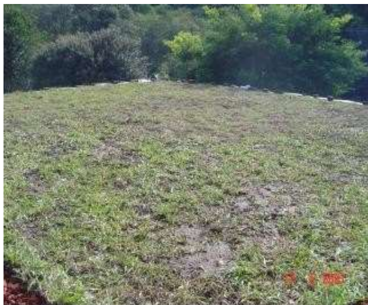
Figura 19- Vista do telhado verde
