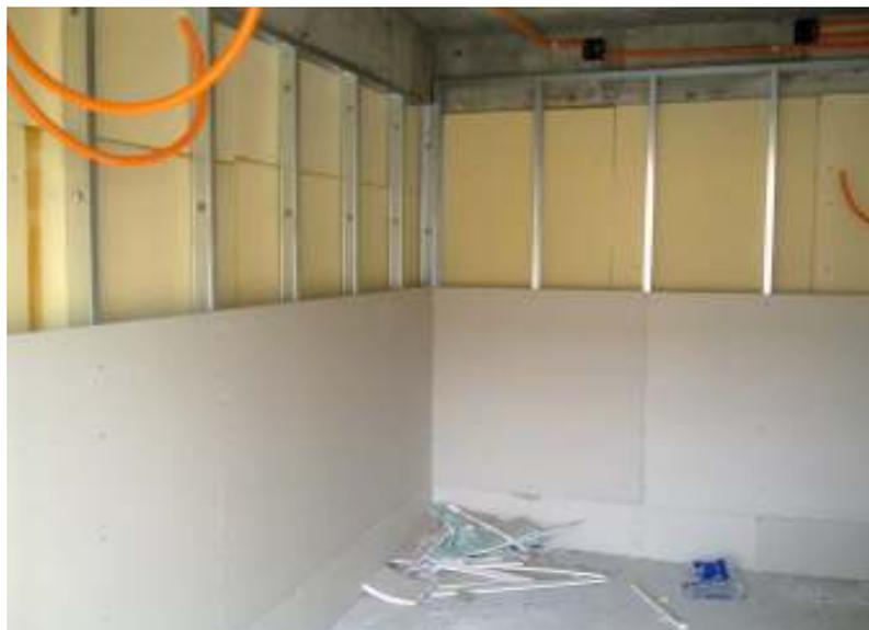
**Figura 19 – Aplicação de espuma de poliuretano como controle térmico**
