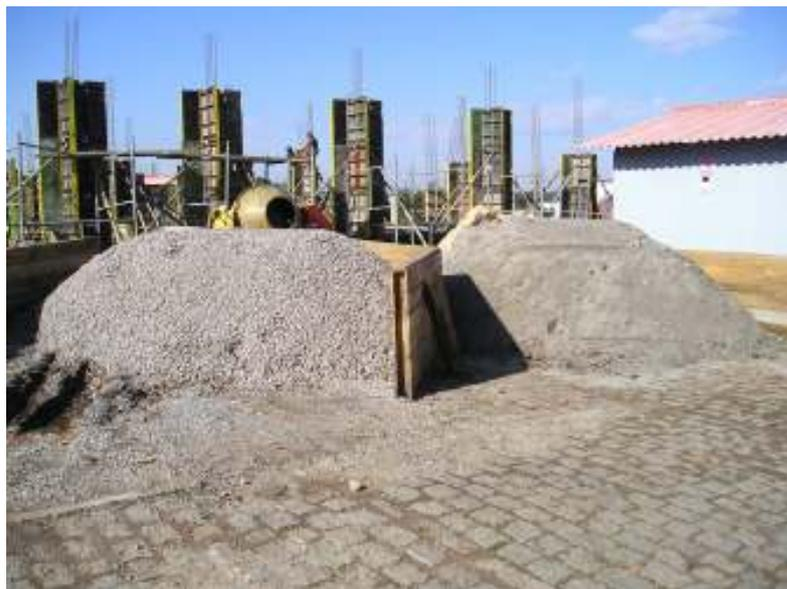
**Figura 18 – separação de material a granel**
