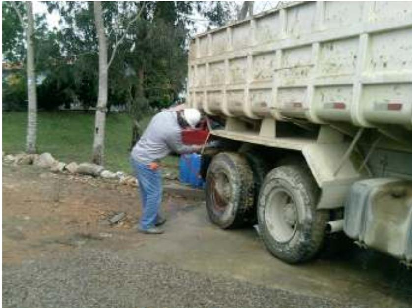
**Figura 13 – Lavagem de rodas dos caminhões na saída da obra**
