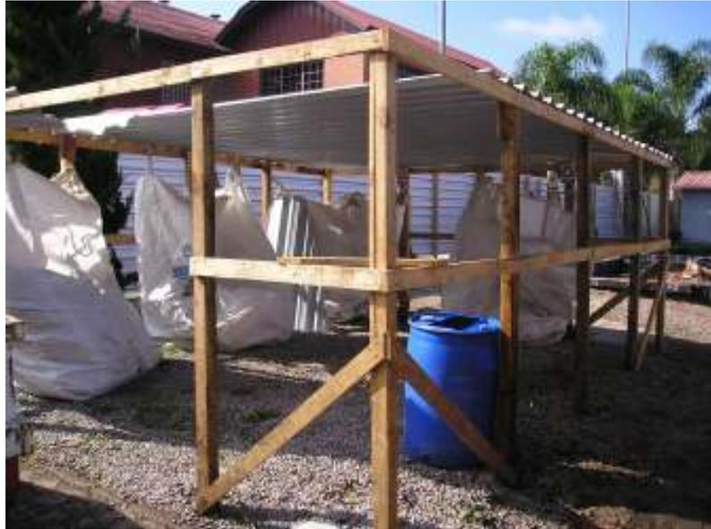
**Figura 17 – Separação de resíduos da construção em bags ou caçambas**
