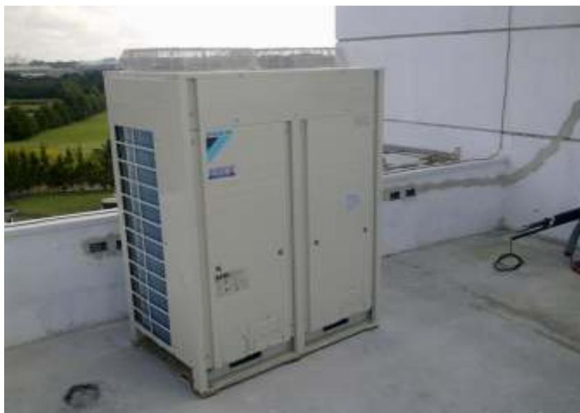
**Figura 22 – Ar condicionado tipo VRF, mais eficiente**
