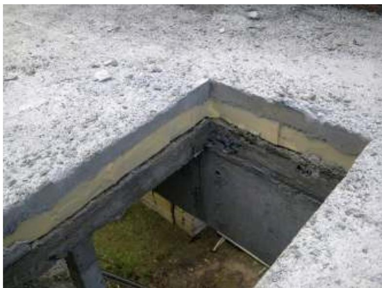
**Figura 20 – Aplicação de espuma de poliuretano como controle térmico**
