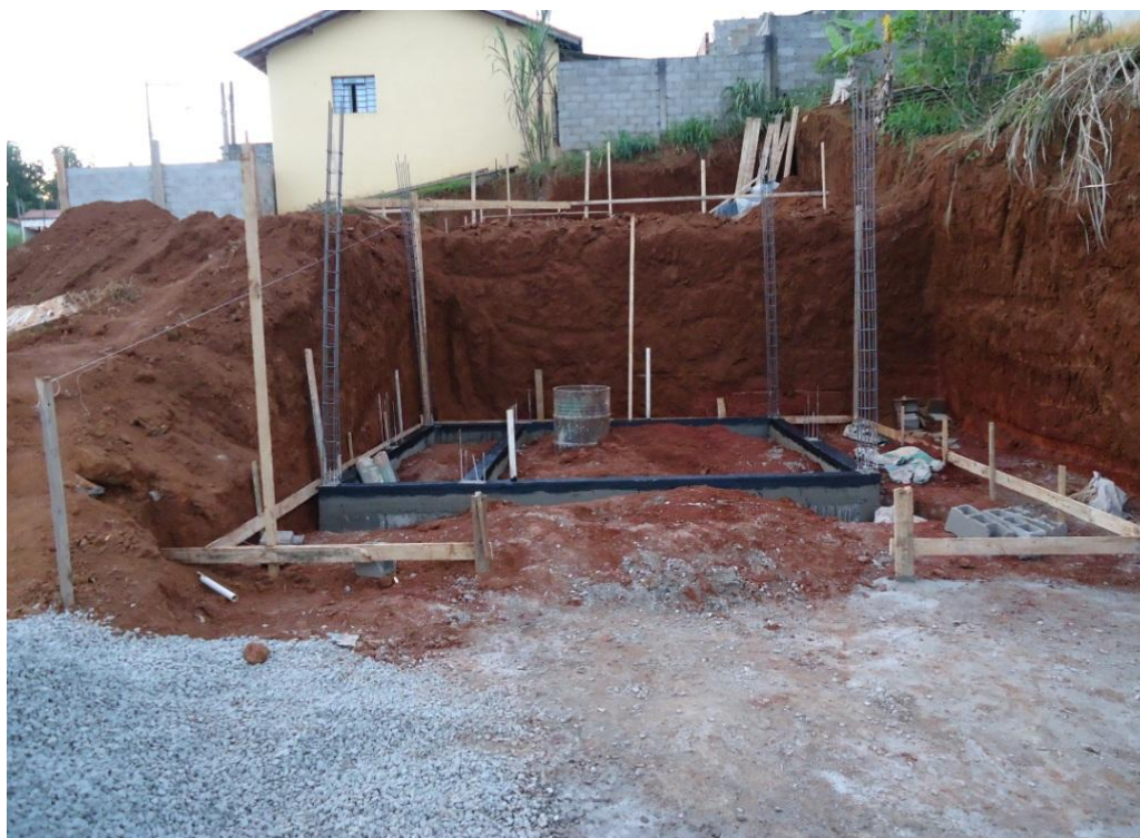
Figura 2 – Terreno e início da obra Fonte: Autor
