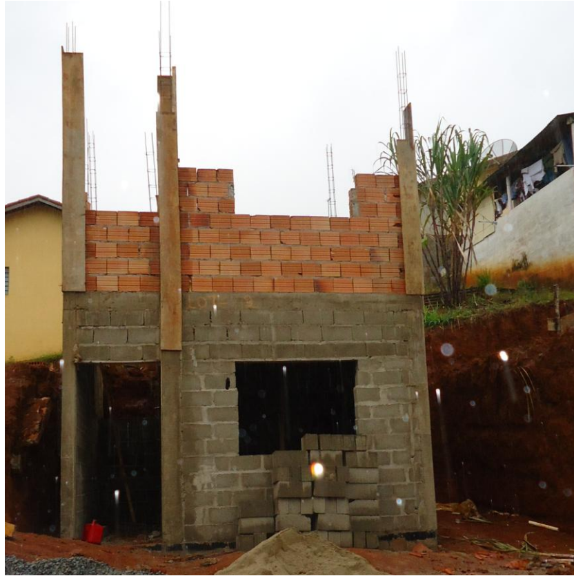
Figura 4– Alvenaria em tijolo cerâmico e bloco de concreto
