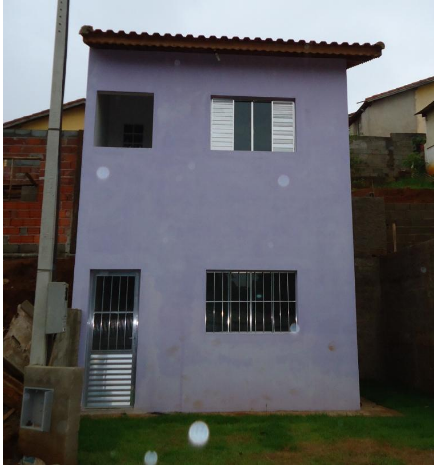
Figura 7 – Obra concluída Fonte: Autor
