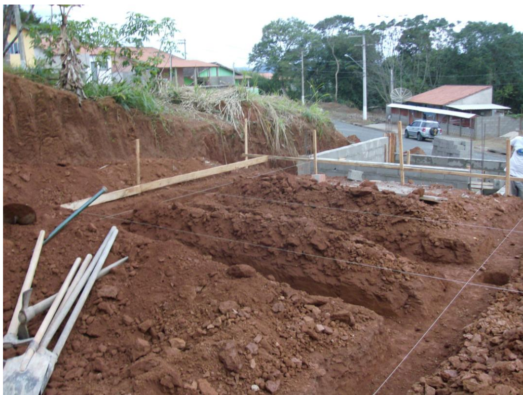
Figura 3 – Terreno e início da obra
