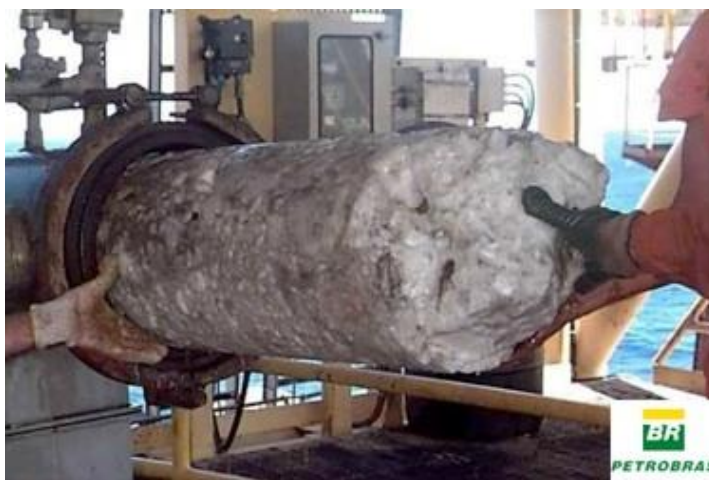
Figura 1.1 - Remoção de um plugue de hidrato de uma tubulação
