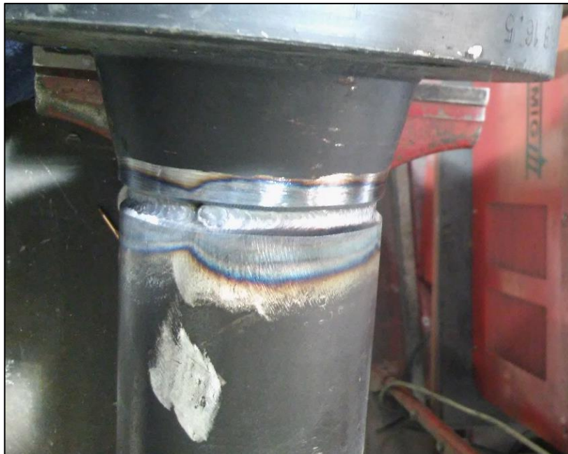
Figura 10: Falha na solda raiz Fonte: Autoria própria.
