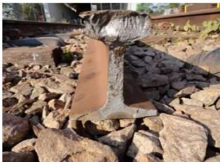
Fotografia 11 – Trinca no patim do trilho
