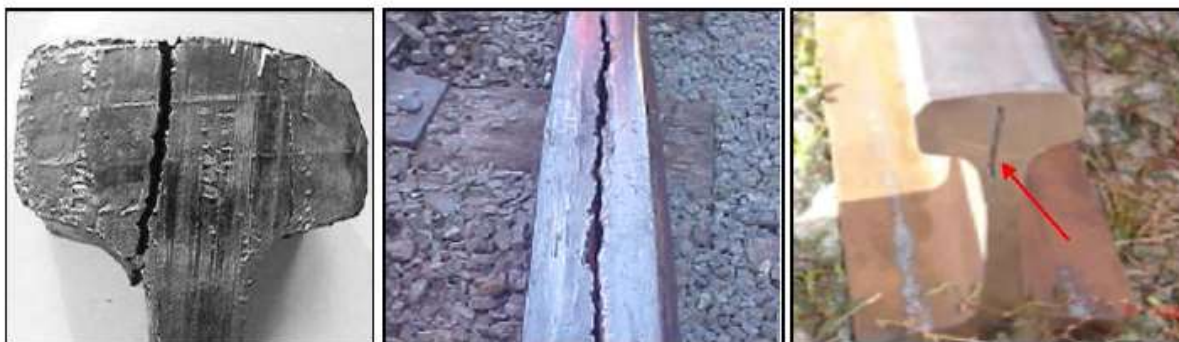
Fotografia 1 – Trinca vertical no boleto
