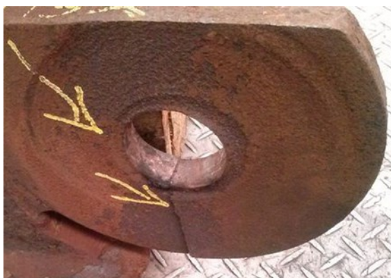
Fotografia 2.2 – Elo Avariado (Trinca)
