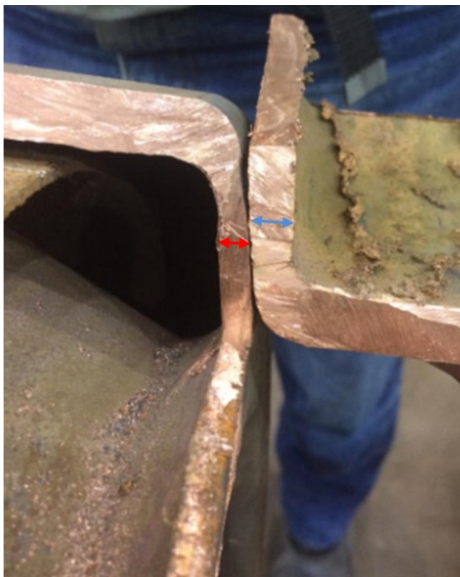
Figura 4.10 – Espessura inadequada de fabricação do bico com fragilidade
