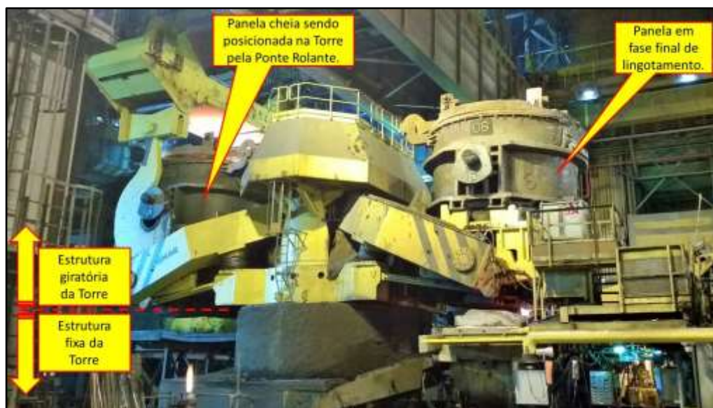
Fotografia 2.1 – Vista lateral da Torre de Panela
