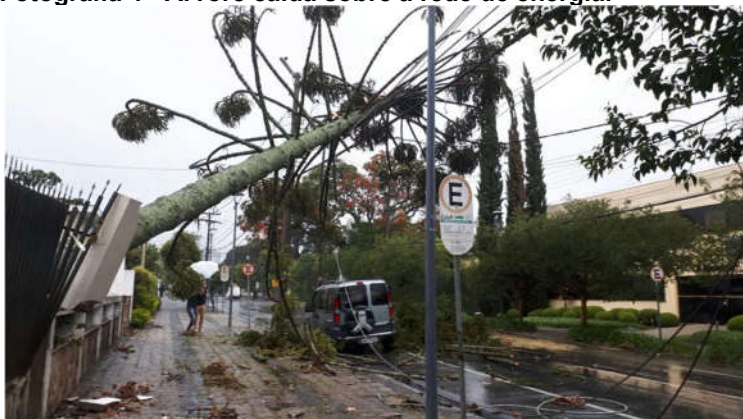
Fotografia 4 - Árvore caída sobre a rede de energia.
