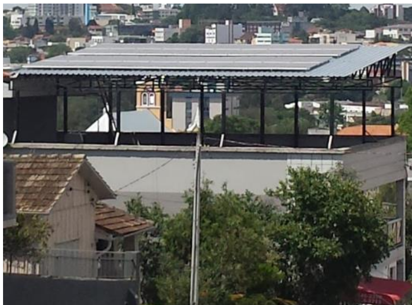
Figura 19 – Vista geral da cobertura da instalação
