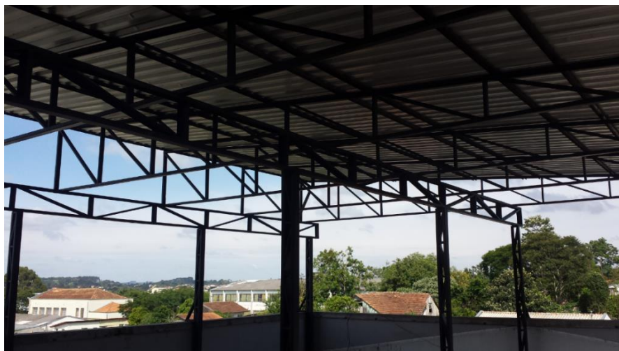
Figura 11 – Estrutura metálica finalizada
