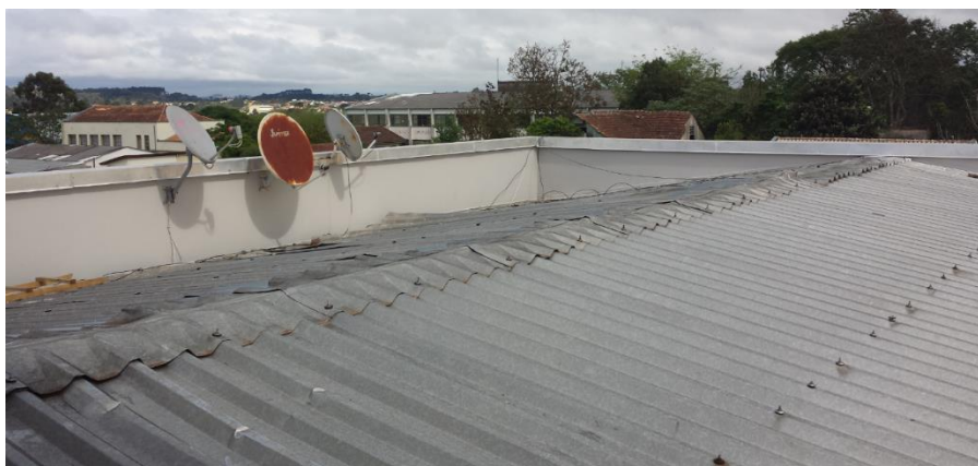
Figura 10 – Vista do telhado antes da instalação do sistema fotovoltaico
